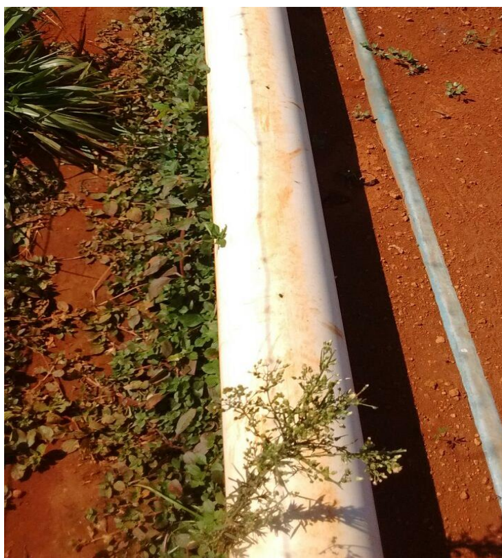
Figura 20 - Dutos de PVC transportadores do esterco entre os canais e os tanques de armazenamento aberto. Fonte: Autor.
