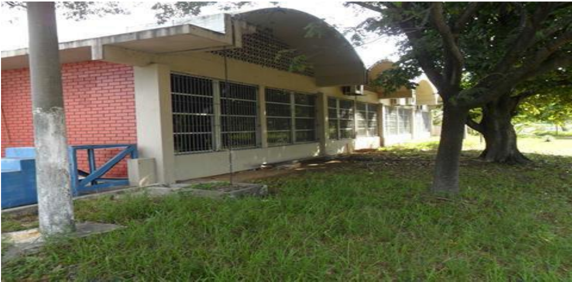
Figura 20 - Vista da fachada norte do edifício administrativo da CODESA. Fonte: CODESA
