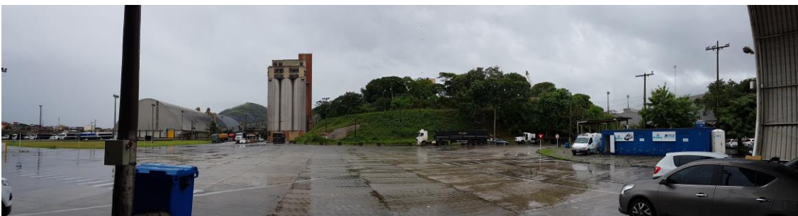
Figura 22 - visão geral da entrada do TeCon de Vitória onde se localiza o CCO. Fonte: Autor
