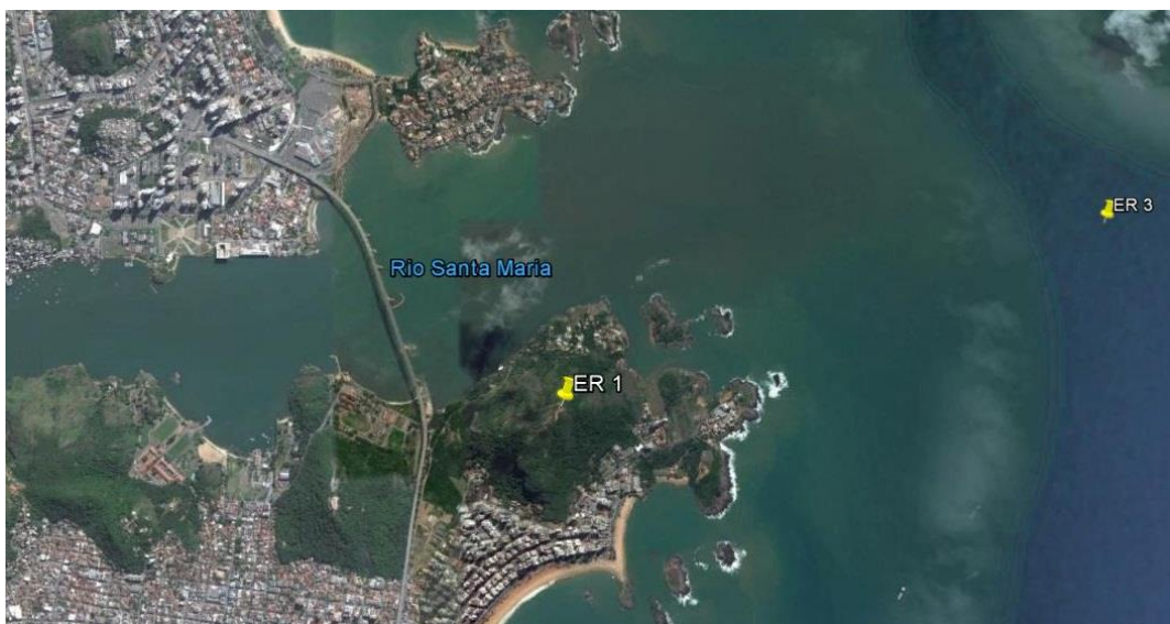
Figura 25 - Vista do local da instalação da Estação Remota 1. Fonte: CODESA
