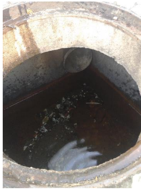
Figura 15: Vista poço de inspeção no Ponto de Coleta 04.
