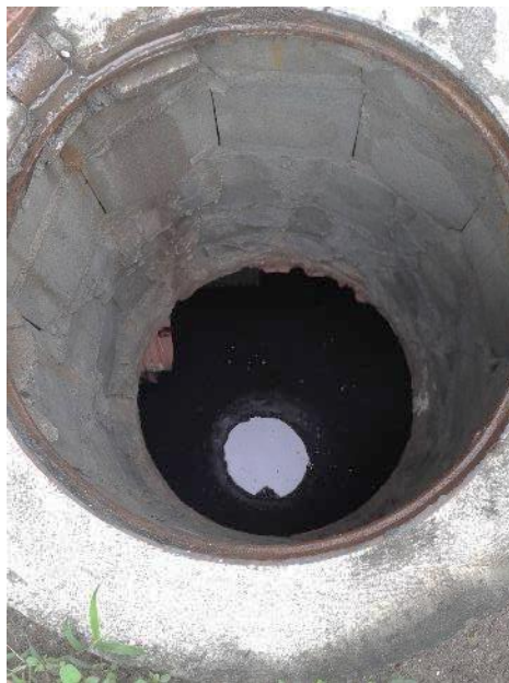
Figura 14: Vista poço de inspeção no Ponto de Coleta 03.
