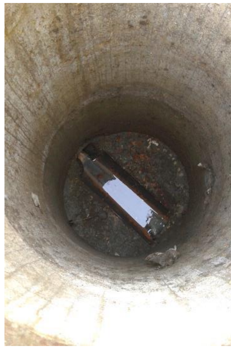
Figura 13: Vista poço de inspeção no Ponto de Coleta 02.
