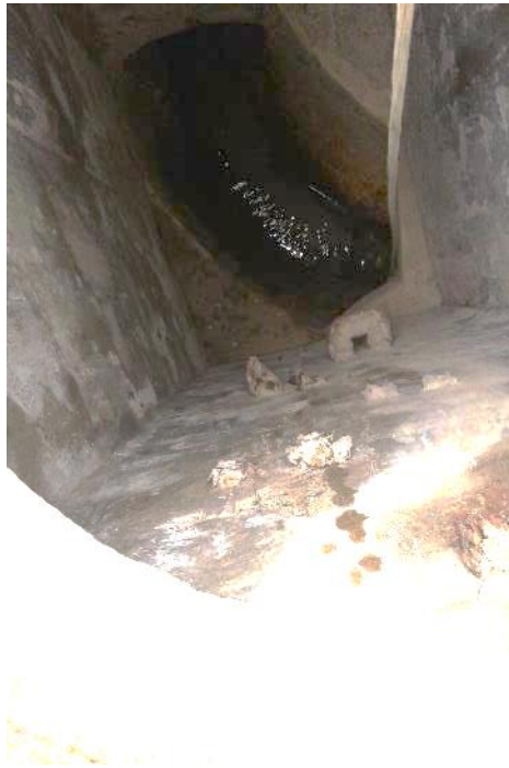
Figura 12: Vista poço de inspeção no Ponto de Coleta 01.
