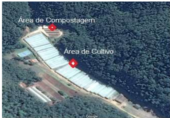
Figura 9 - Vista área do Rancho SFP, mostrando as estufas e a área destinada a compostagem.
