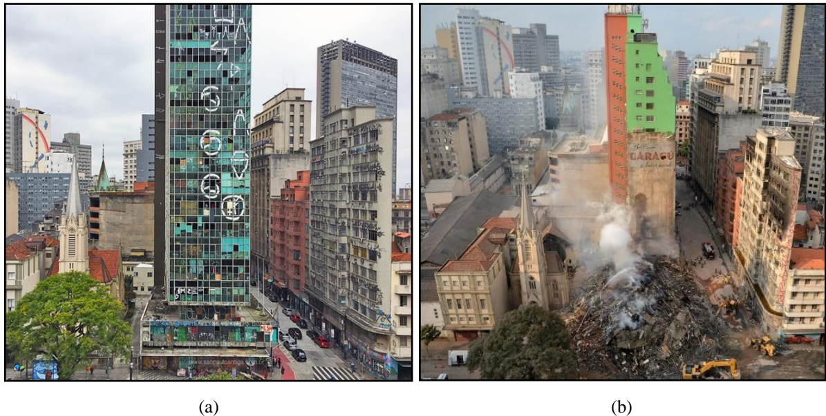
Figura 3 (a) e (b) – Edifício Wilton Paes de Almeida localizado em São Paulo em 2016 e em 2018, após ruína Jornal Grande Bahia (2018)
