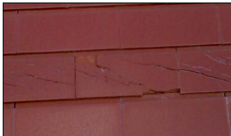
Figura 20 - Fissuração no revestimento cerâmico CHAVES (2009)
