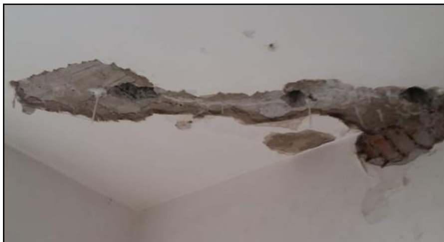
Figura 28 - Patologias no concreto ocasionadas pela má impermeabilização de laje de cobertura
