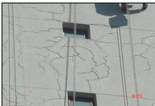
Figura 22 - Fissuração típica na argamassa por movimentação térmica SAHADE (2005)
