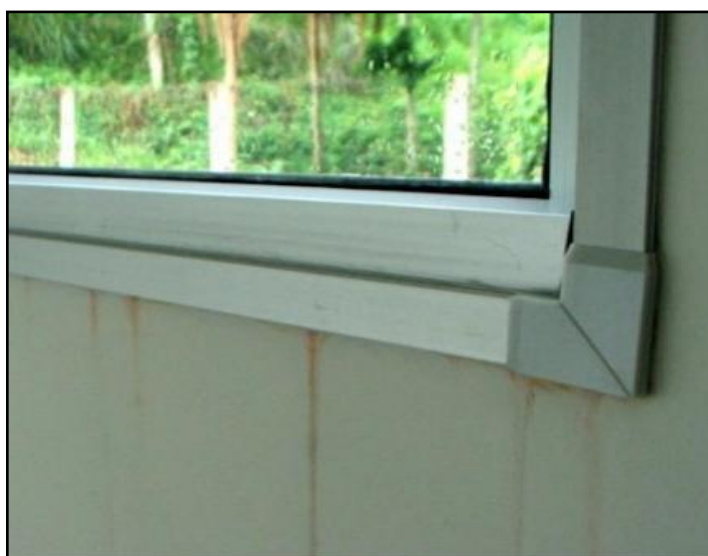
Figura 26 - Infiltração por falta de estanqueidade da esquadria AFEAL (Disponível em: http://afeal.com.br/ 2019)
