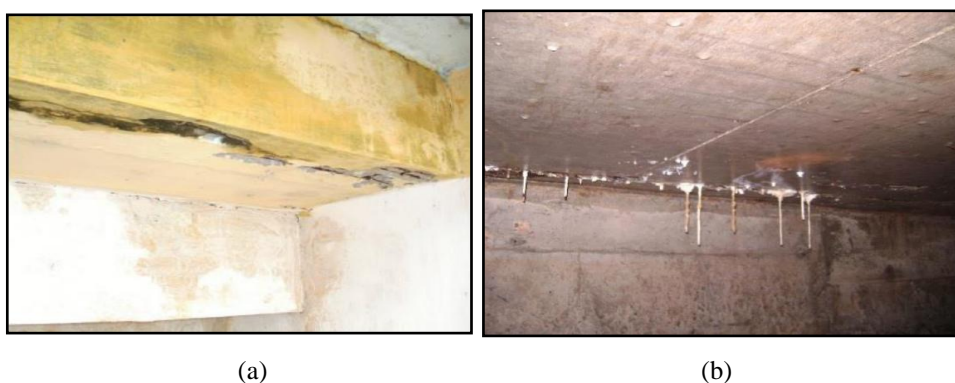
Figura 14 - (a) Desagregação do concreto (b) Eflorescência SILVA (2011)
