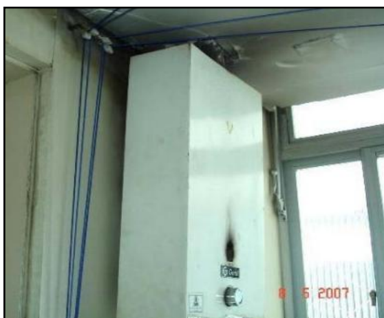
Figura 32 - Aquecedor de passagem a gás desprovido de chaminé individual e em ambiente sem ventilação permanente (GNIPPER, 2010)
