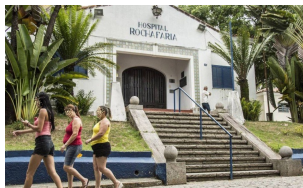
Figura 16 – Hospital Rocha Faria em 2018.
