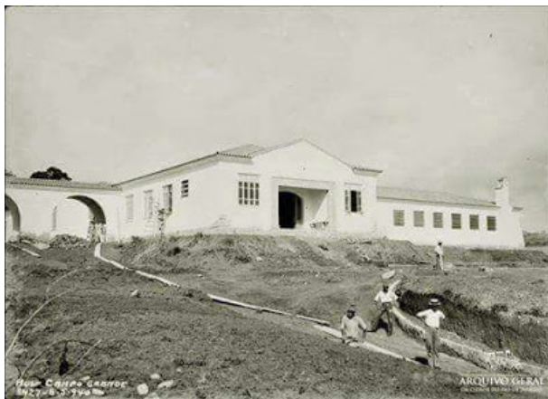
Figura 15 – Hospital Rocha Faria em 1940.
