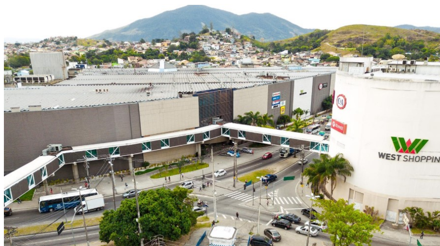
Figura 17 – Fachada do West Shopping de frente para a Estrada do Mendanha. Fonte: http://www.westshopping.com.br/shopping.php . Acesso em 05/10/2019.
