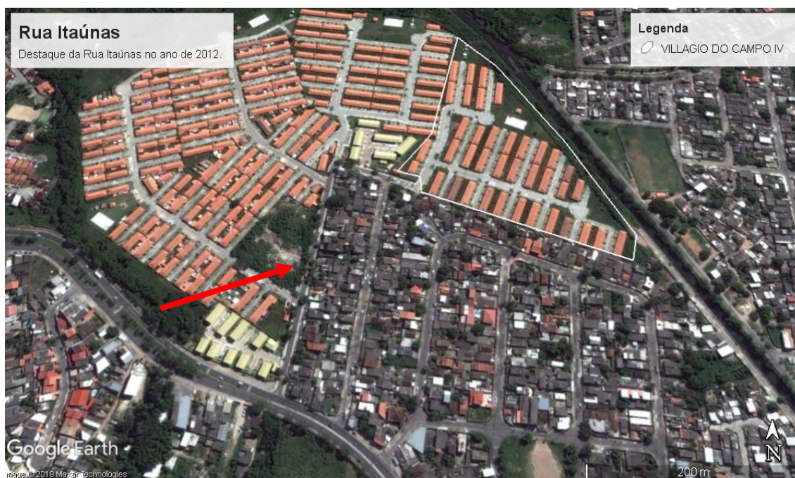
Figura 41 – Imagem aérea da Rua Itaúnas em abril de 2012. Fonte: Google Earth, 2019. Adaptado pelo autor.
