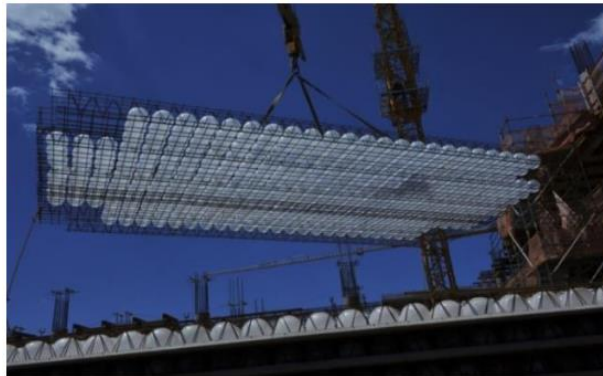
Figura 2.11: Módulo de painel de armadura para laje BubbleDeck (BLUBBLEDECK DO BRASIL, 2019).
