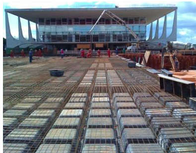
a) Montagem das formas e armaduras.
