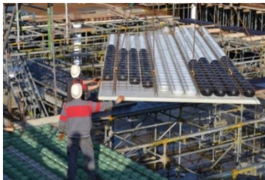
Figura 2.12: Posicionamento de pré-laje BubbleDeck (BUBBLEDECK DO BRASIL, 2019).
