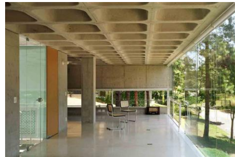
b) Laje desformada.
