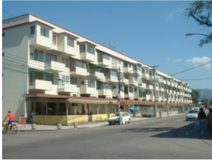
Figura 2: IAPI Realengo RJ. Fonte: LabHab UFRJ.
