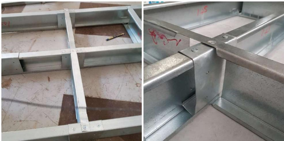
Figura 41 – Detalhe de fixação entre as peças de aço, com uso de parafusos auto atarraxantes com cabeça flangeada #4,8x19mm e ponta broca
