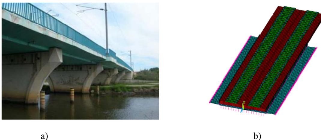
Figura 2.33 – a) Ponte de Canelas; b) Modelo numérico, desenvolvido em Silva (2010).
