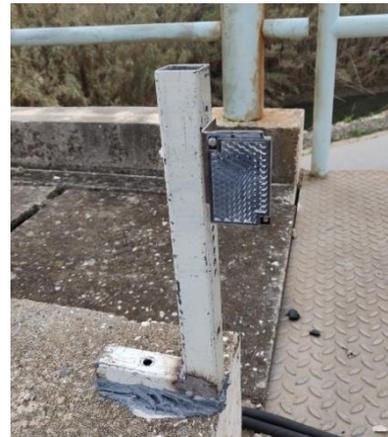
Figura 3.16 – Sistema de deteção da passagem de comboios
