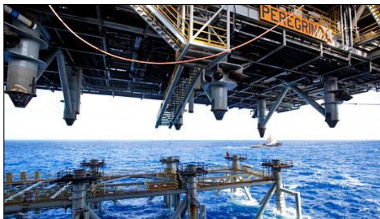
Figura 16 - Plataforma fixa de Peregrino. Fonte: STATOIL (2011).
