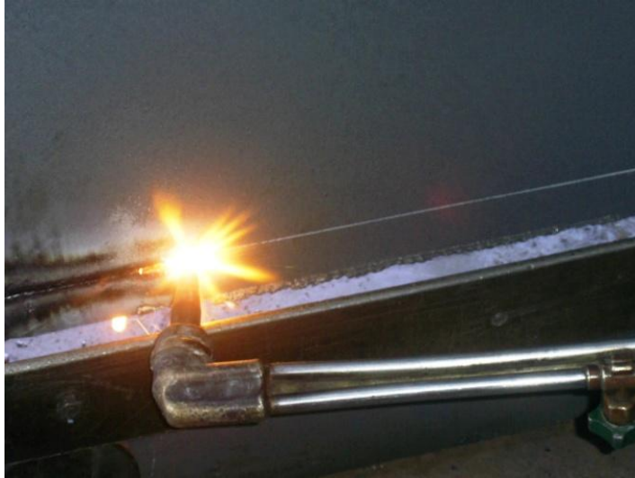
Foto 15 – Bloco sendo ajustado nas dimensões. Fonte: o autor.
