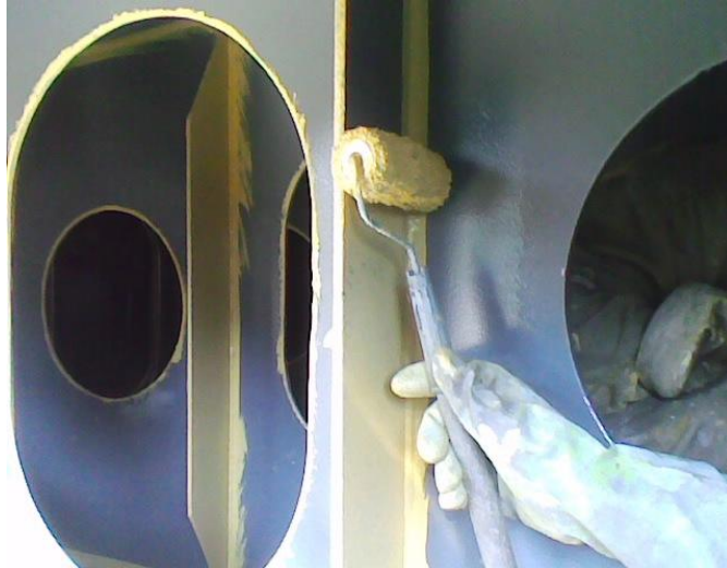
Foto 45 – Aplicação de tinta nos cantos. Fonte: o autor.
