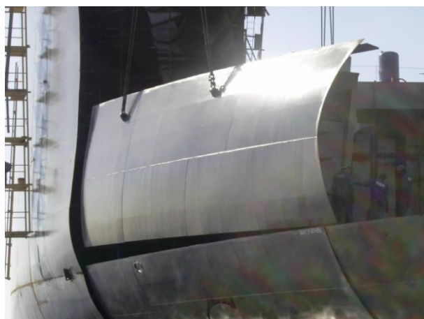
Foto 12 – Edificação de um bloco. Fonte: o autor.
