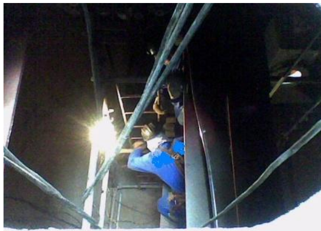
Foto 36 – Desmontagem de andaime. Fonte: o autor.
