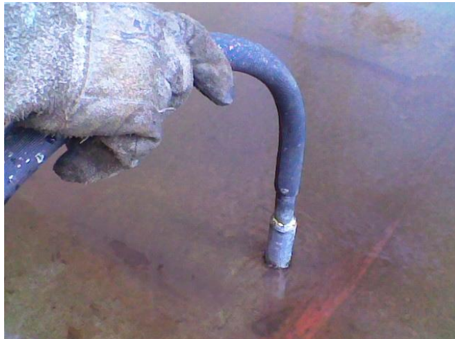
Foto 22 – Retirada de água do fundo de um tanque. Fonte: o autor.
