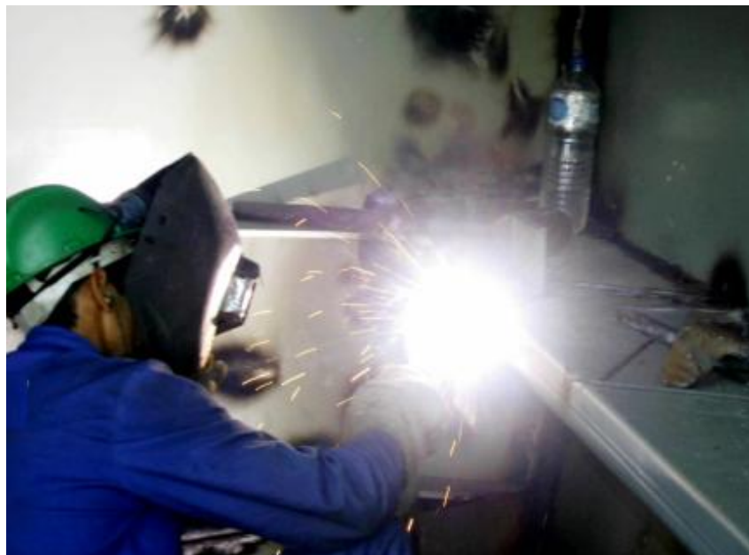
Foto 14 – Serviço de solda em espaço confinado.
