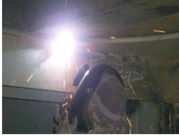
Foto 04 – Serviço de solda no interior do bloco. Fonte: o autor.
