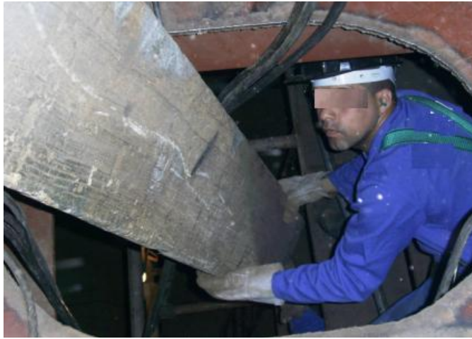
Foto 20 – Montagem de um andaime em espaço confinado. Fonte: o autor.
