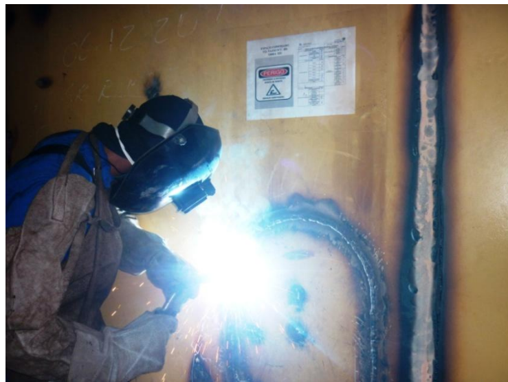
Foto 61 – Realizando o processo de soldagem. Fonte: o autor.
