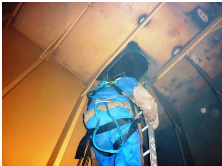
Foto 65 – Soldador saindo do espaço confinado. Fonte: o autor.
