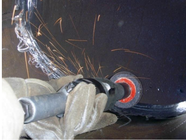
Foto 25 – Esmerilhamento de solda. Fonte: o autor.
