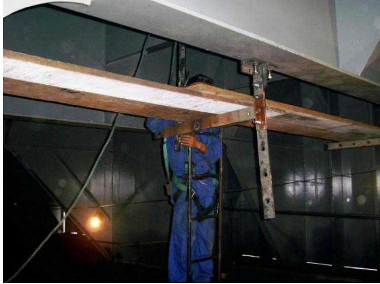
Foto 32 – Montagem de andaime. Fonte: o autor.
