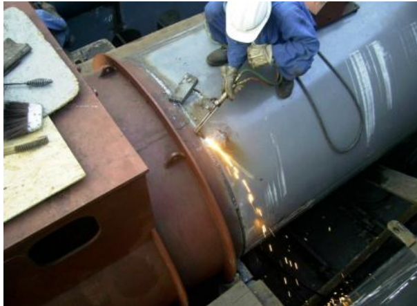
Foto 26 – Maçariqueiro executando corte na tubulação. Fonte: o autor.
