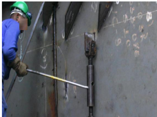
Foto 03 – Alinhamento do bloco com esticador. Fonte: o autor.
