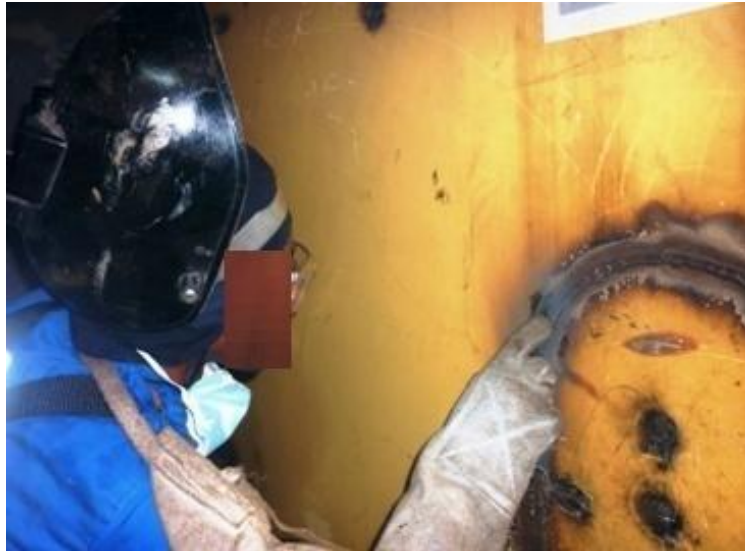
Foto 64 – Realização da inspeção da solda. Fonte: o autor.
