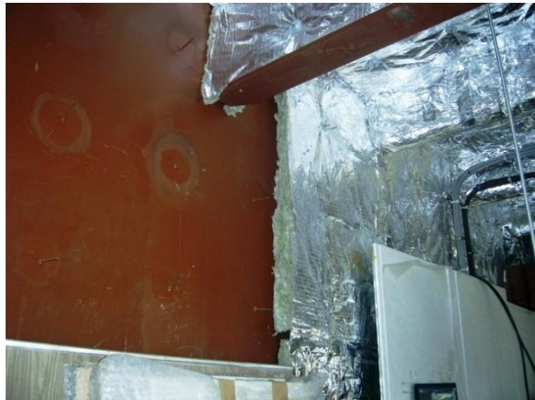
Foto 30 – Colocação do isolamento e do acabamento na antepara. Fonte: o autor.
