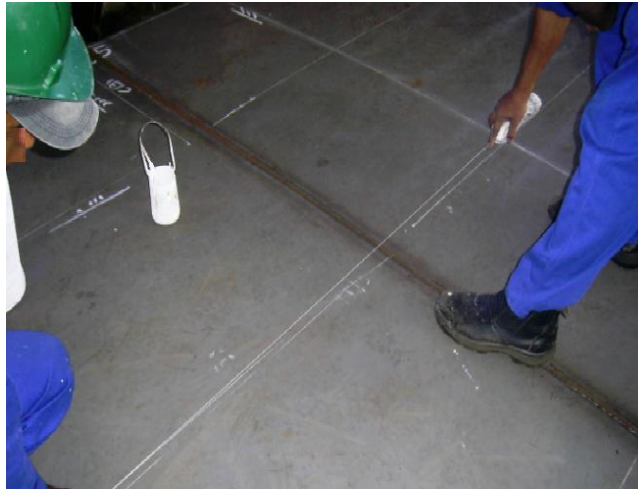
Foto 01 – Riscadores marcando a chapa base. Fonte: o autor.
