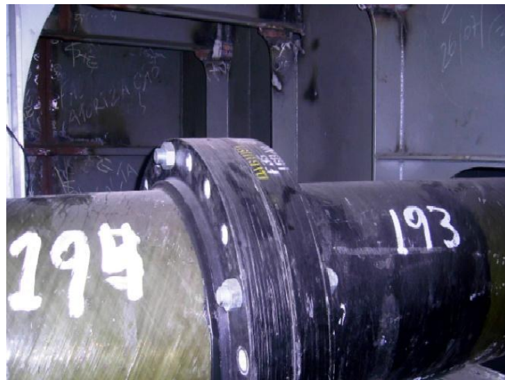
Foto 19 – Tubulações montadas. Autor: o autor.
