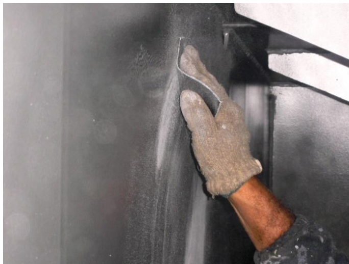
Foto 41 – Lixamento manual. Fonte: o autor.
