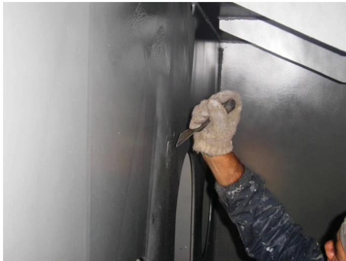
Foto 40 – Remoção de tinta com espátula. Fonte: o autor.
