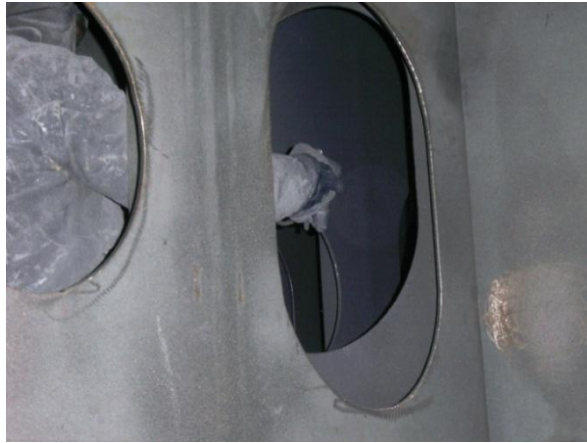
Foto 7 – Aplicação da proteção. Fonte: o autor.
