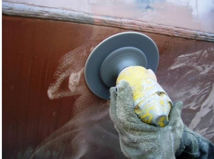
Foto 42 – Lixamento mecânico. Fonte: o autor.
