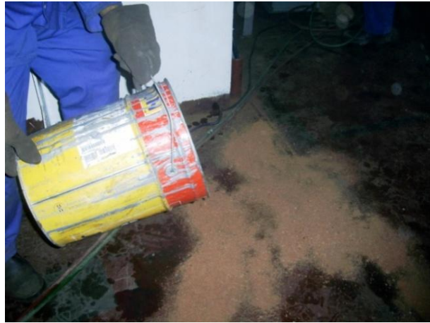
Foto 34 – Limpeza do piso com a utilização de serragem. Fonte: o autor.
