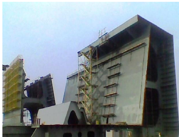
Foto 11 – Deslocamento de anéis. Fonte: o autor.
