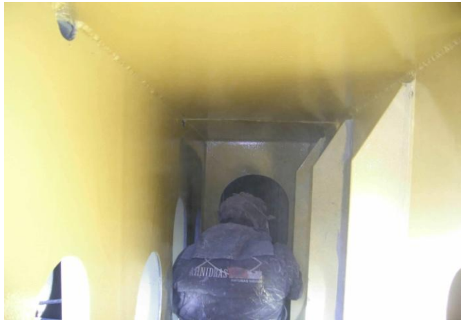
Foto 46 – Pintura no espaço confinado. Fonte: o autor.
