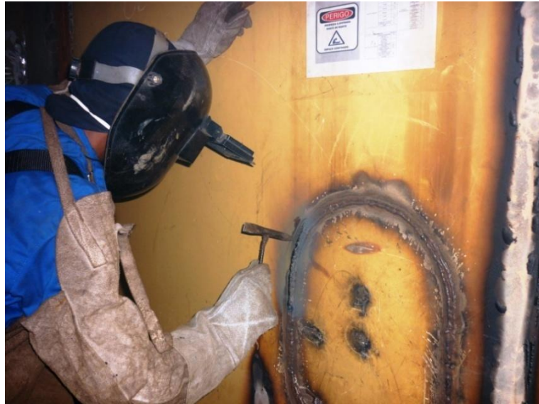
Foto 62 – Soldador dissipando as tensões. Fonte: o autor.
