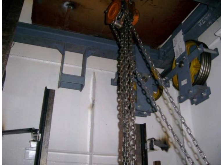
Foto 28 – Montagem do elevador. Fonte: o autor.
