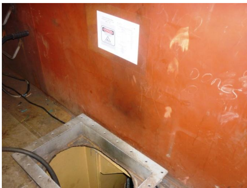
Foto 50 – Espaço confinado devidamente sinalizado e identificado.
