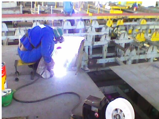
Foto 02 – Execução dos primeiros serviços de solda na chapa base. Fonte: o autor.
