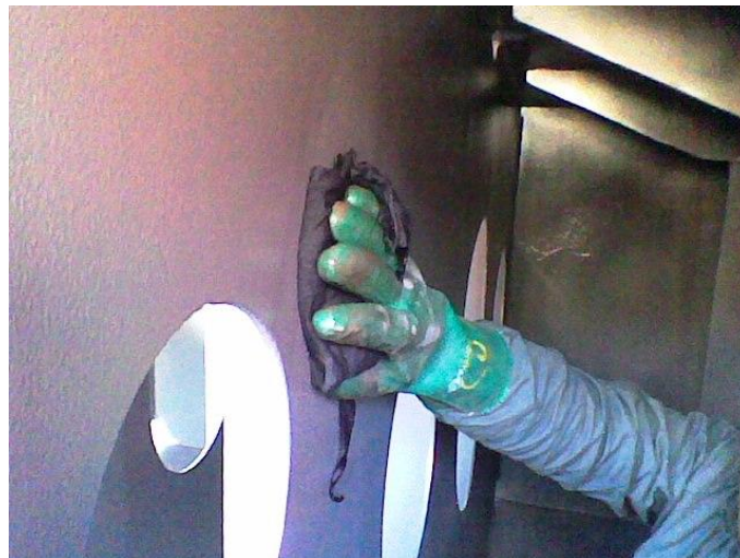
Foto 44 – Execução do tratamento químico. Fonte: o autor.
