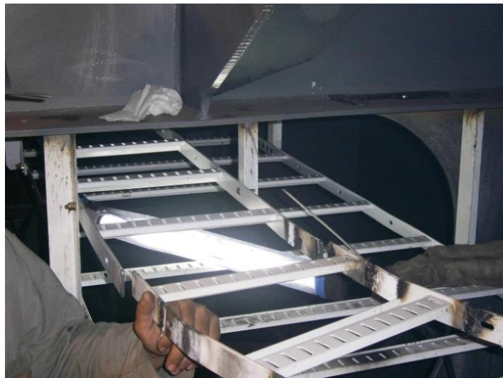
Foto 37 – Montagem de uma calha elétrica.
