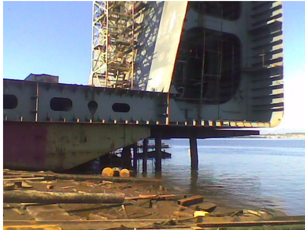
Foto 10 – Anel posicionado na carreira de lançamento. Fonte: o autor.
