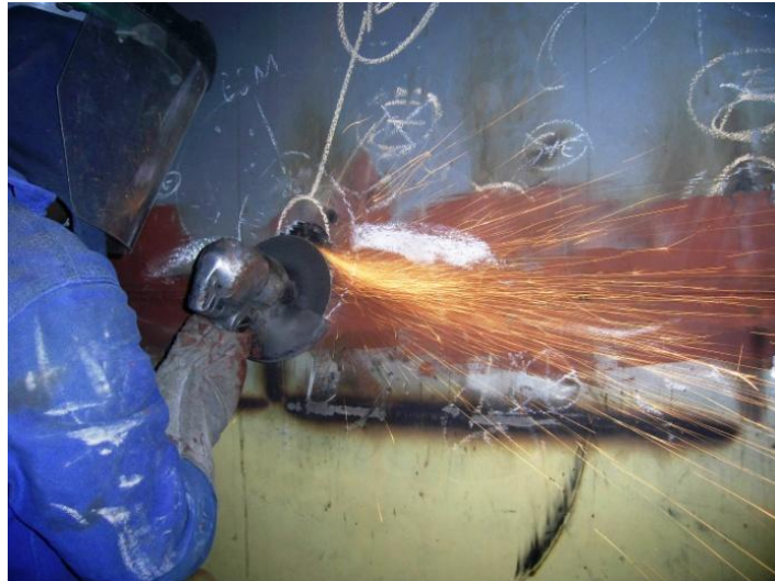
Foto 16 – Esmerilhamento de solda. Fonte: o autor.
