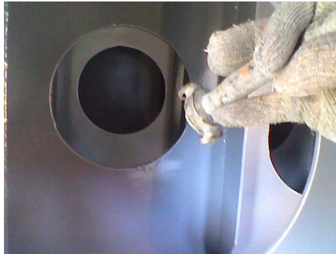
Foto 43 – Remoção das impurezas com ar comprimido. Fonte: o autor.
