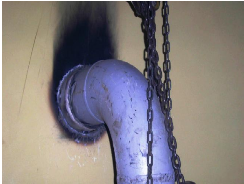
Foto 23 – Tubulação posicionada. Fonte: o autor.
