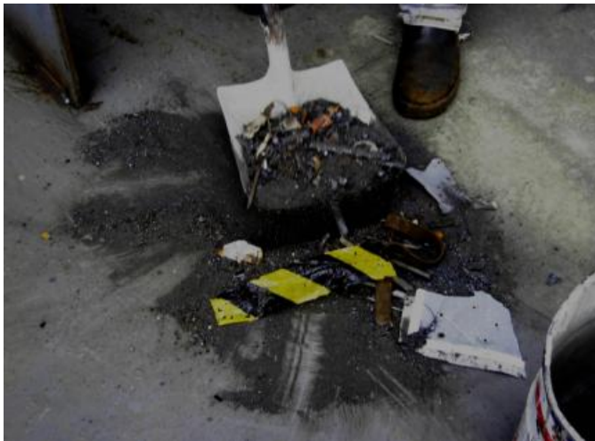
Foto 21 – Remoção de resíduos. Fonte: o autor.
