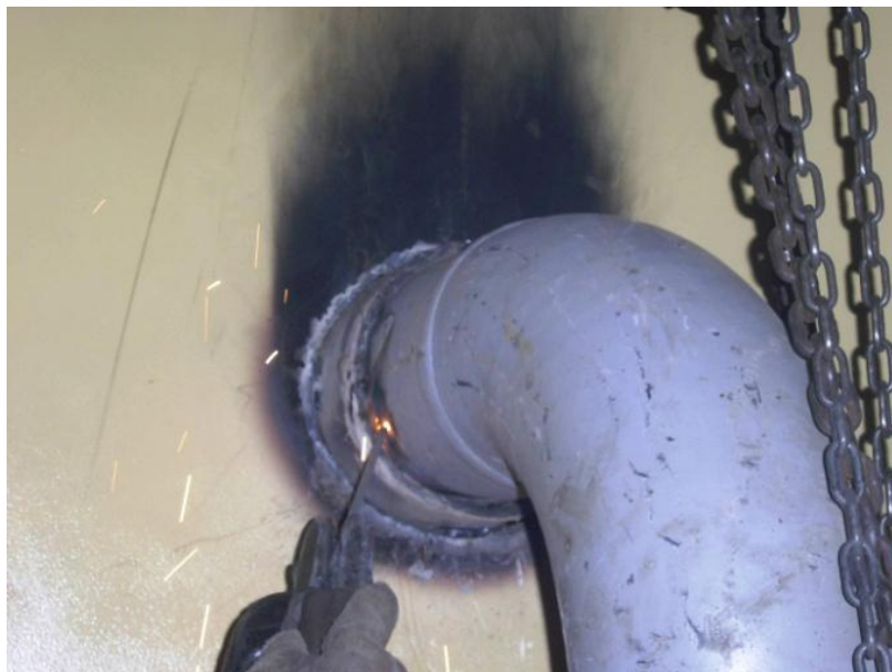
Foto 24 – Tubulação sendo soldada. Fonte: o autor.
