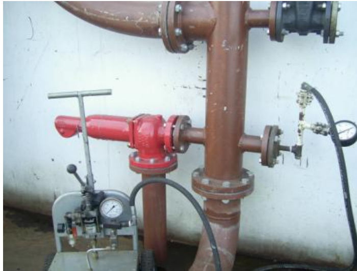
Foto 49 – Teste na rede de incêndio. Fonte: o autor.
