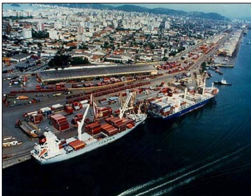
Figura 5 – Foto aérea do Porto de Santos, SP
