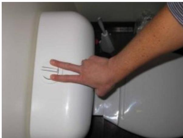
Figura 30 – instalação de vasos com caixa acoplada e sistema duplo de acionamento. Fonte: Arktos Arquitetura, 2011.
