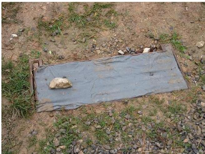
Figura 21 – Grelha com proteção de Manta tipo Bidim para evitar evasão de sedimentos.
