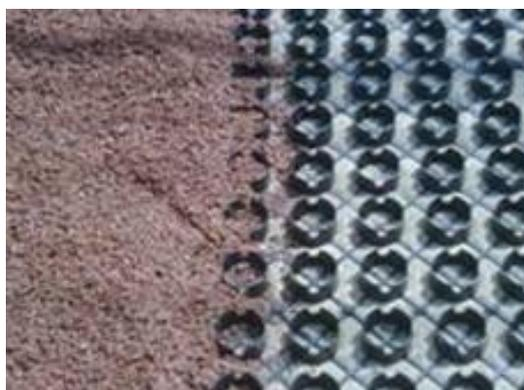
Figura 28– Aplicação de Ecopiso que aumenta a permeabilidade do solo. Fonte: Ecotelhado, 2010
