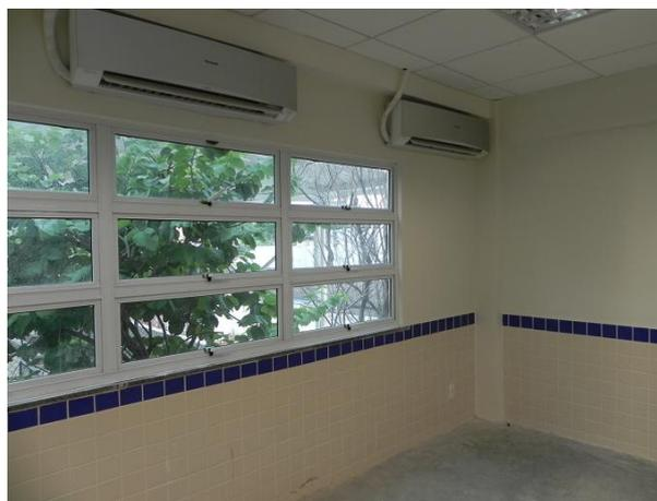
Figura 39 – aparelhos de ar condicionado silenciosos, esquadrias com proteção acústica e teto em placa acústica de fibra mineral modelo furado. Fonte: do pesquisador, 2011.
