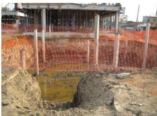
Figura 27 – Escavação dos reservatórios de captação de águas pluviais. Fonte: Acade Arquitetura, 2010.
