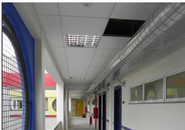
Figura 37 – Dutos de insuflamento de ar exterior fazem a renovação de ar dos ambientes. Fonte: do pesquisador, 2011.
