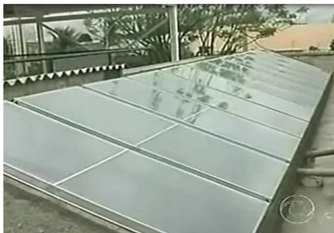
Figura 32 – Coletores solares para aquecimento de chuveiros no vestiário. Fonte: Rede Record, 2011.
