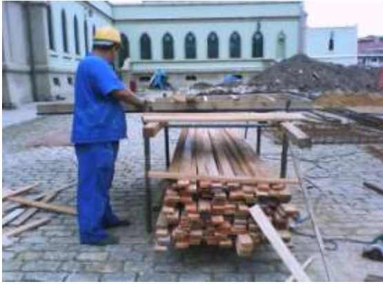
Fig. 11 – Montagem de formas.
