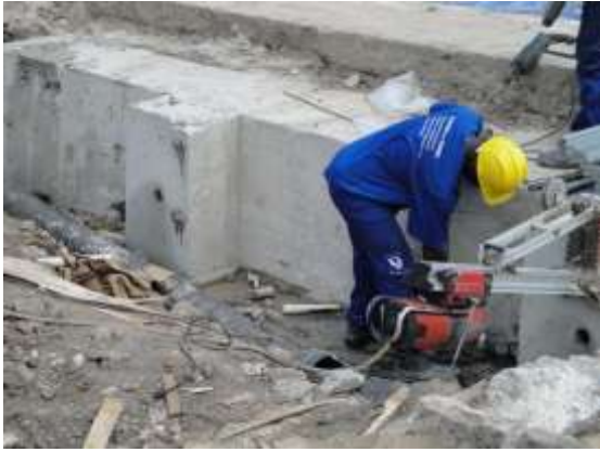
Fig. 35- Perfuração do contraforte para instalação de tirante. Fig. 36 – Instalação do tirante.
