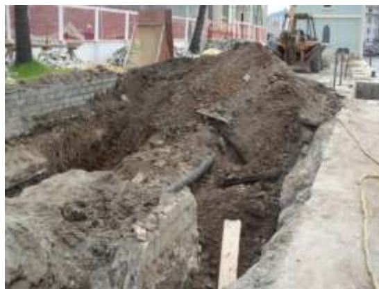
Fig. 28 – Exposição da galeria de suprimentos.
