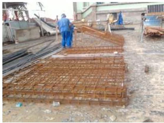
Fig. 16 – Armação das placas.
