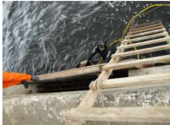
Fig. 14 – Fixação de forma com apoio de mergulhador.
