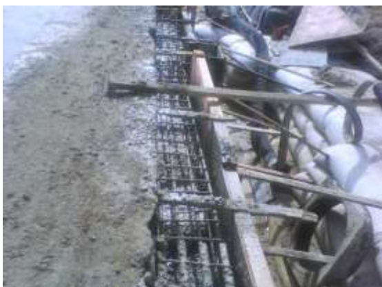
Fig. 33 – Concretagem de viga e contraforte.
