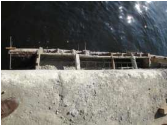
Fig. 23 – Concretagem de forma de placa.
