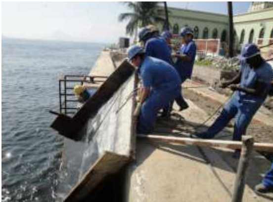
Fig. 13 – Equipe de carpinteiros e ajudantes apoiando a instalação de forma.
