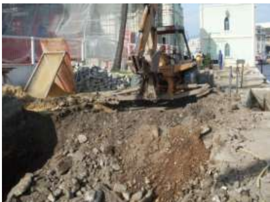
Fig. 27 – Escavação mecanizada.
