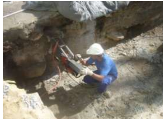
Fig. 24 – Perfuração para instalação de chumbador.
