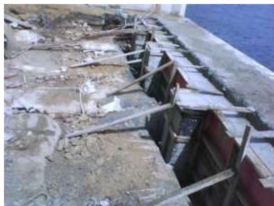
Fig. 34- Construção de viga e contraforte.
