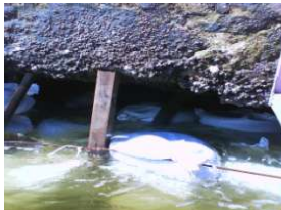
Fig. 20 – Preparação para instalação de última camada de bolsacreto.
