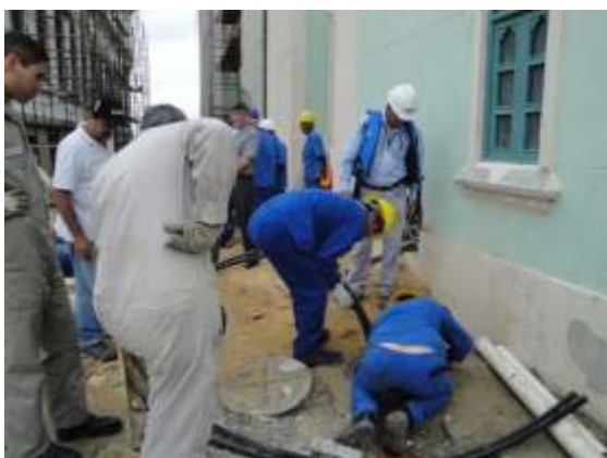
Fig. 25 – Remoção instalação elétrica alta-tensão.
