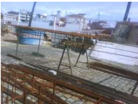
Fig. 15 – Corte e dobra de ferragens para estrutura.
