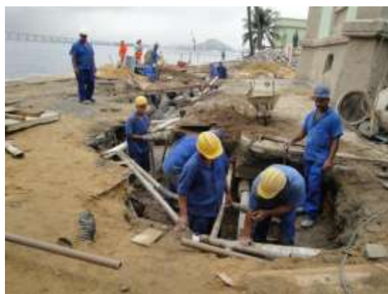
Fig. 26 – Remoção rede água e esgoto.
