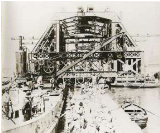
Fig. 2- Construção da muralha de cais. Embarcação, guindaste à vapor e tina no primeiro plano e ensecadeira no segundo plano.
