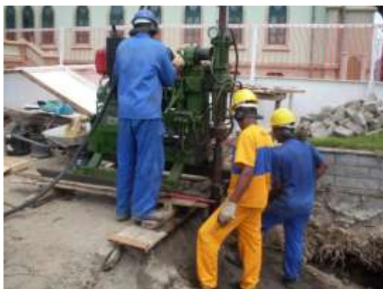
Fig. 9 – Instalação do equipamento de sondagem.
