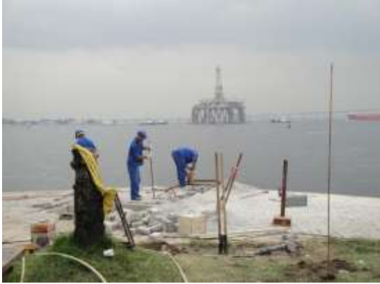
Fig. 38 - Reinstalação da pavimentação.
