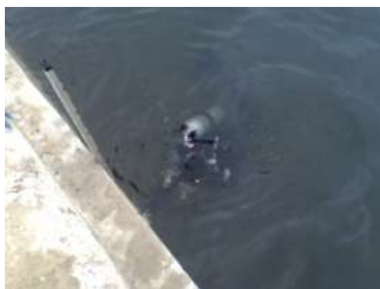
Fig. 10 – Inspeção do paramento do cais.
