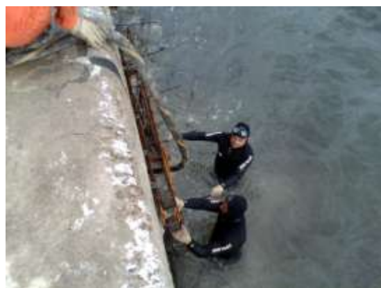
Fig. 18 – Instalação do mangote flexível.
