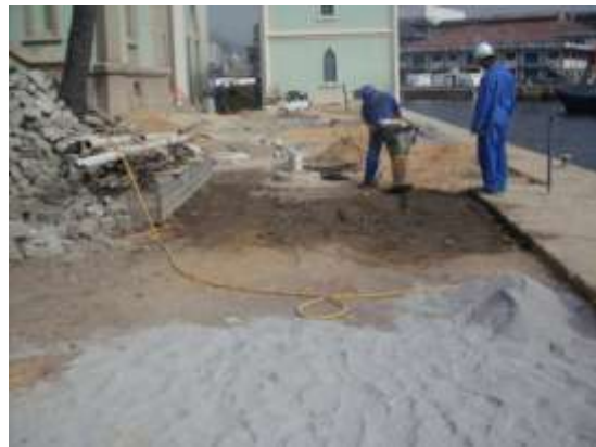
Fig. 32 – Reaterro e compactação de solo.
