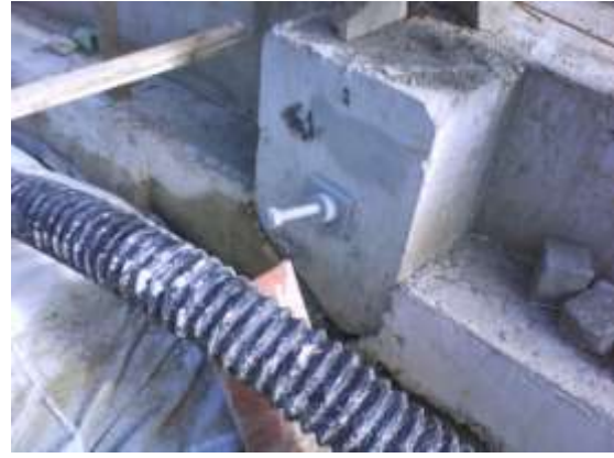
Fig. 35- Perfuração do contraforte para instalação de tirante. Fig. 36 – Instalação do tirante.
