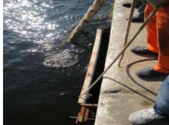
Fig. 22 – Perfuração de paramento para instalação de chumbador.
