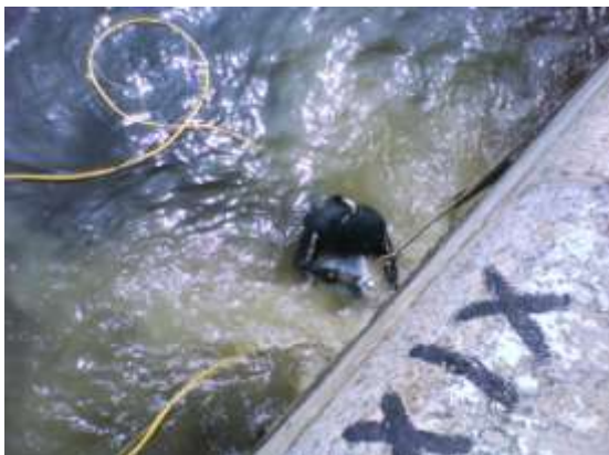
Fig. 19 – Concretagem de bolsacreto.
