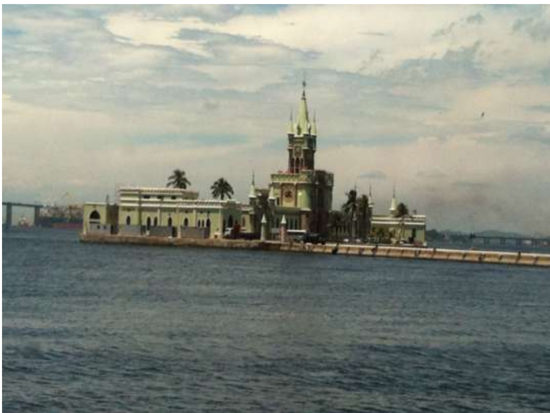
Fig. 5 – Ilha Fiscal vista do cais sudoeste.
