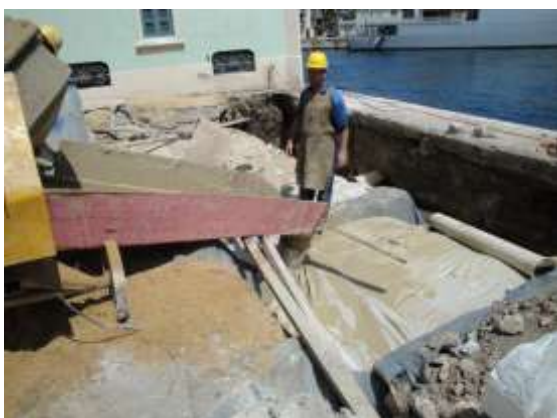
Fig. 29 – Enchimento do bolsacreto na retroárea.
