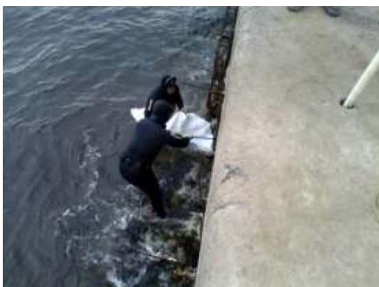
Fig. 17 – Instalação do bolsacreto na caverna
