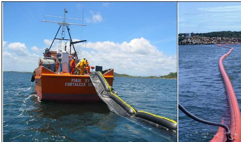
Figura 3-27 – Fotos com barreiras tipo cortina. À esquerda, uma barreira com gomos. À direita, uma barreira contínua (Fonte: INTERNATIONAL DIRECTORY OF OIL SPILL CLEANUP CONTRACTORS, 2011).
