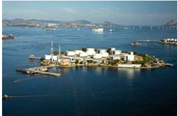
Figura 9. Terminal da Ilha d'Água, Rio de Janeiro (Fonte: http://www.petrobras.com.br/pt/quem-somos/principais-operacoes/ ).
