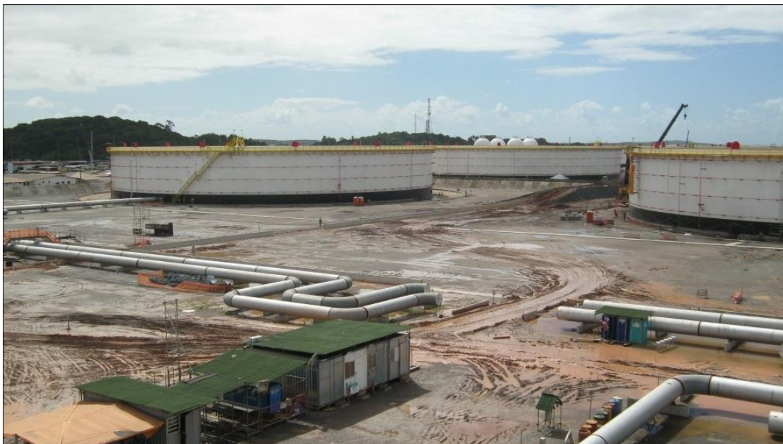
Fig. 2.2: Parque de armazenamento em construção.
