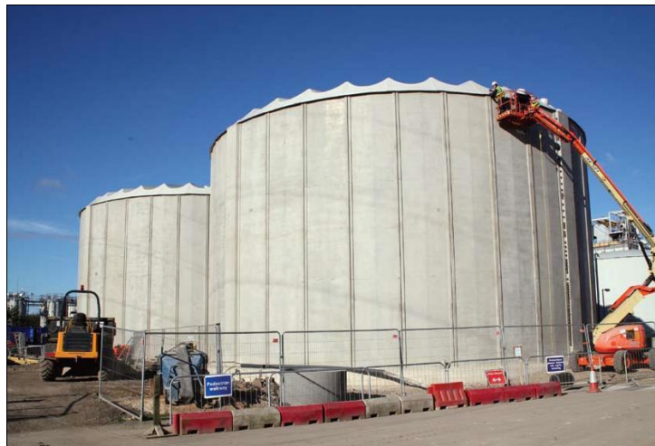
Fig. 2.13: Tanques em elementos protendidos pré-fabricados, para armazenamento de água e efluentes; Leeds, Inglaterra (A-CONSULT LTD, 2011).
