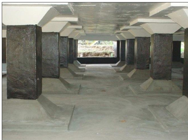
Fig. 2.11: Mesoestrutura de um tanque de armazenamento convencional (em aço) elevado; Rio de Janeiro, RJ (RIBEIRO, 2012).
