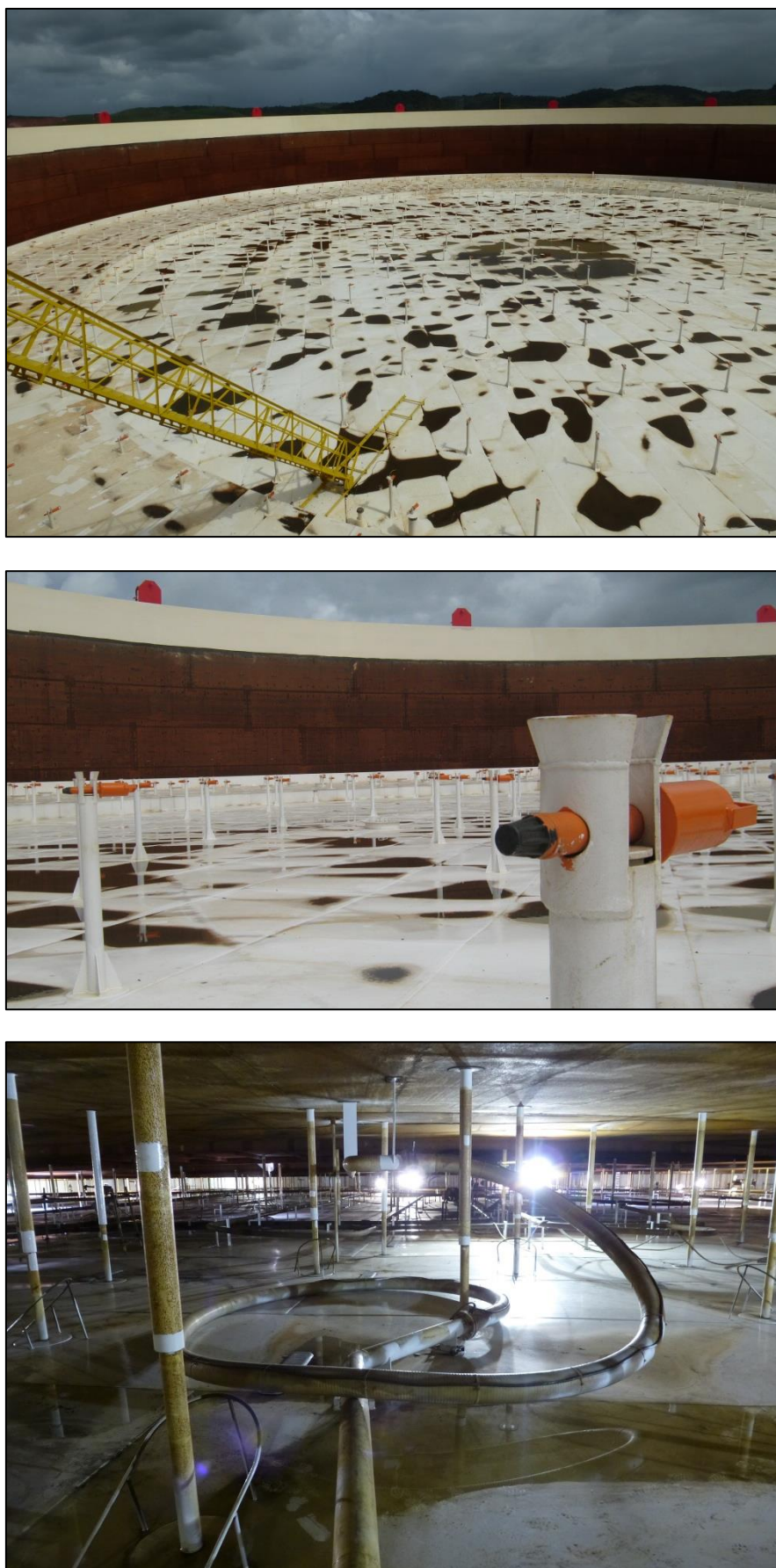
Fig. 3.50: Diversas perspectivas de um mesmo teto flutuante (externo), apresentando alguns de seus acessórios (escada articulada, pernas de sustentação e dreno pluvial flexível).
