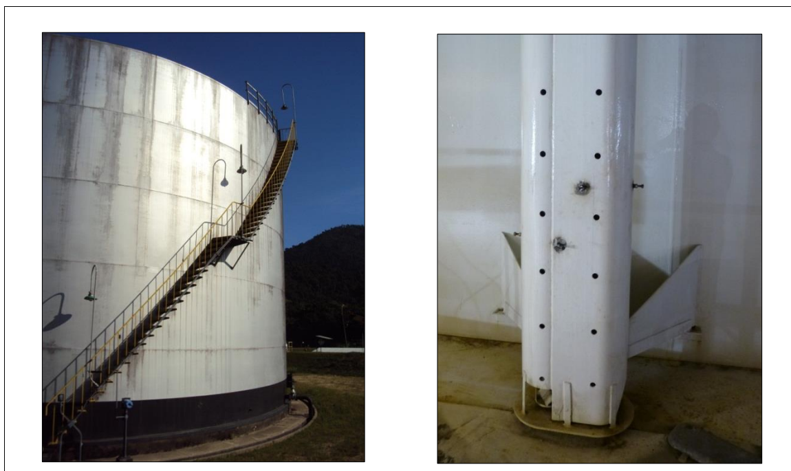
Fig. 3.49: Escada helicoidal de costado (esq.) e mesa de medição de nível (dir.) de tanques de aço.
