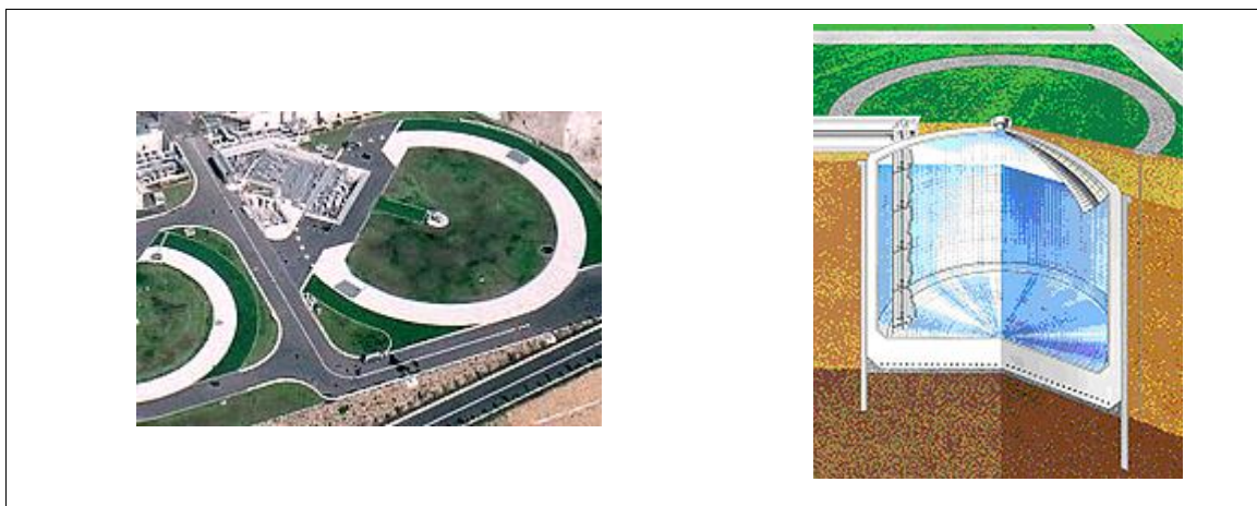
Fig. 2.7: Tanque enterrado para GNL; Yokohama, Japão (TOKYO GAS CO., LTD, 2012).
