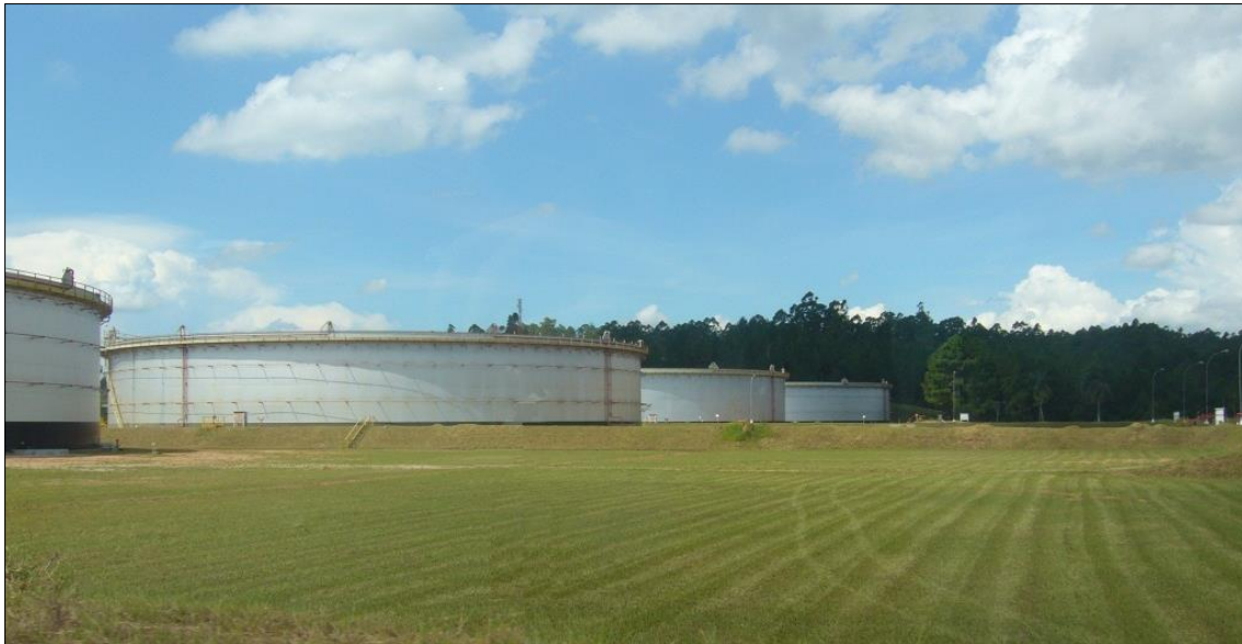
Fig. 2.3: Parque de armazenamento em operação.
