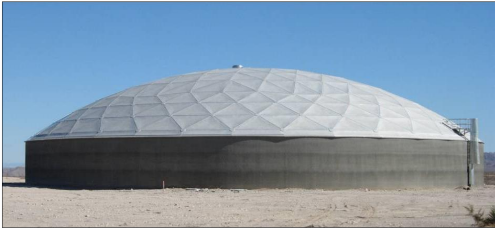
Fig. 2.12: Reservatório protendido moldado in loco (com domo geodésico em alumínio), para armazenamento de cerca de 11.000m 3 de água; Nevada, EUA (LESLIE & ASSOCIATES, INC, 2012).
