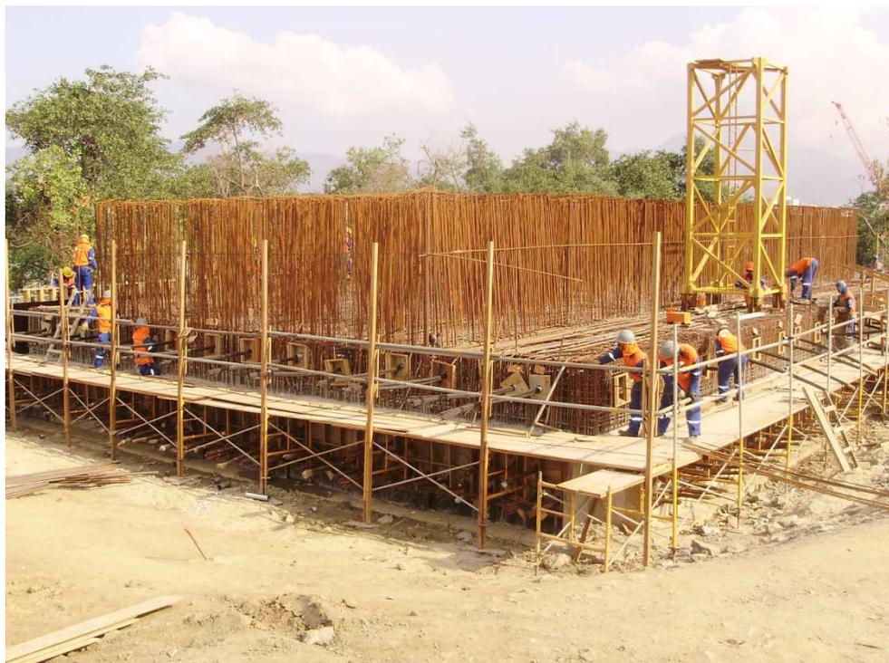
Figura 3.7 – Execução do bloco de fundação do pilone.
