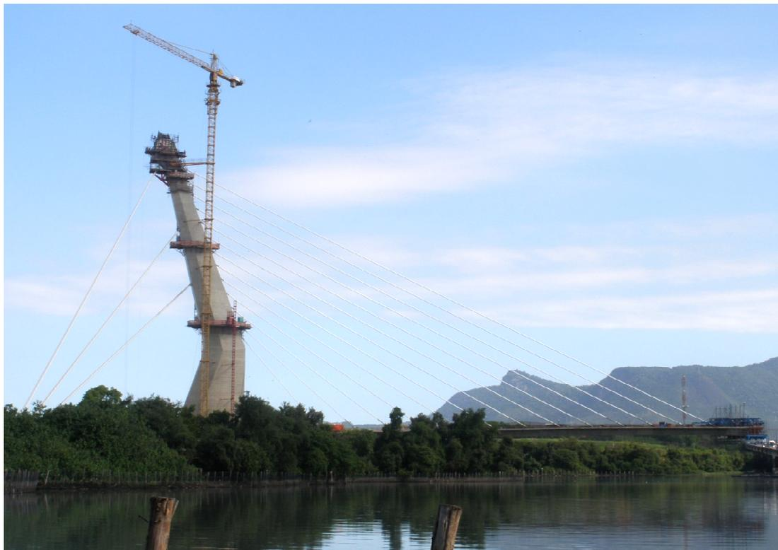
Figura 3.22 – Execução do tabuleiro em balanços progressivos.
