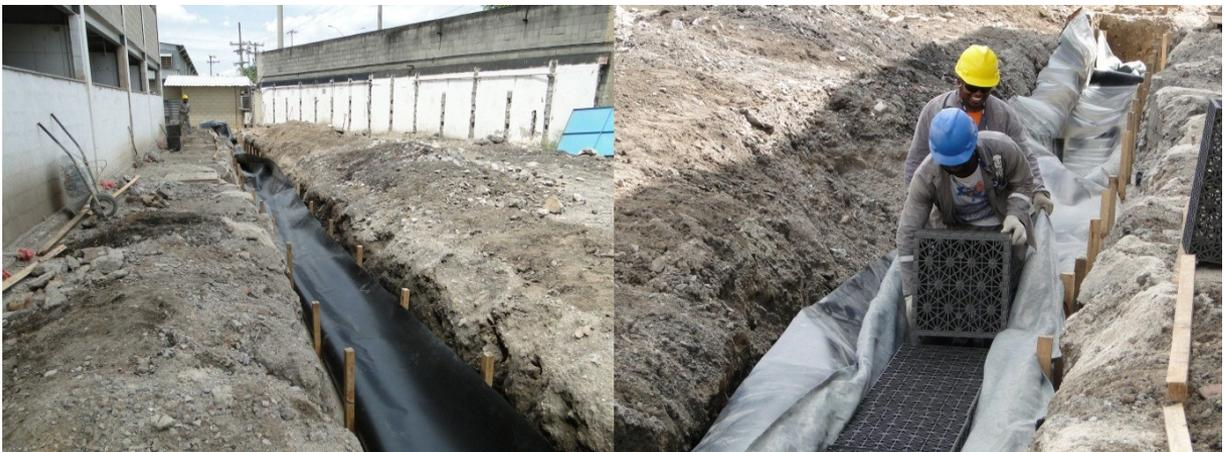
Figura IX: Fotos da instalação do Sistema de Drenagem e Armazenamento da água Pluvial (UTC, 2010).
