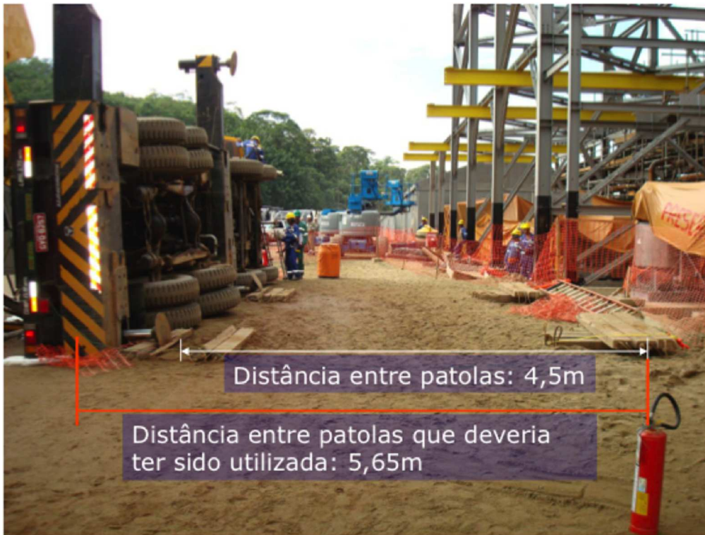
Figura 4.2-3: Patolas esquerdas retraídas do guindaste caminhão XCMG QY50K (arquivo pessoal)
