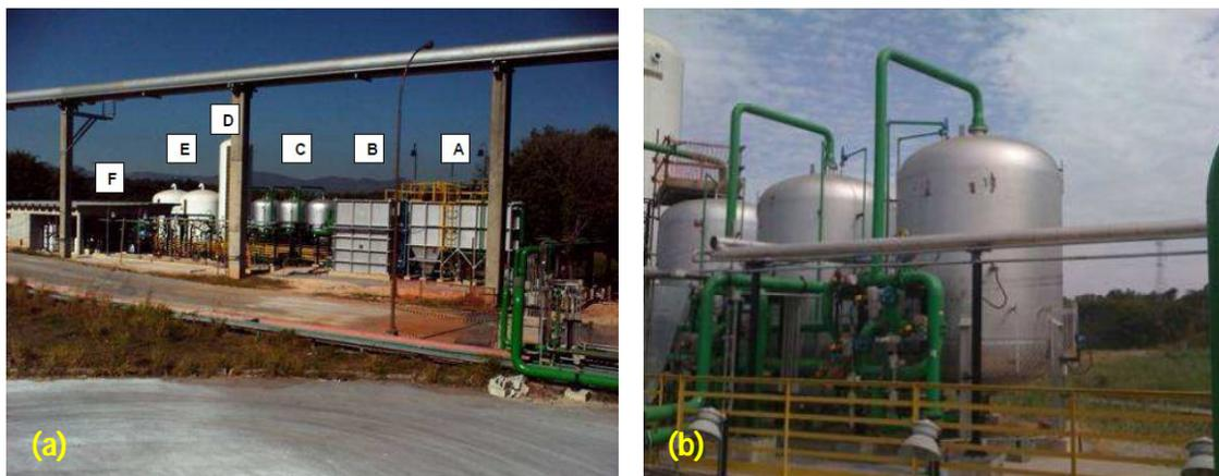
**Figura 18: (a) A) Actiflo, B) Filtros de areia, C) Filtros de CAG, D e E) Tanque de alimentação para EDR e F) EDR; e (b) Detalhe do filtro de carvão ativado. Fonte: Florido e Santiago, (2009).**
