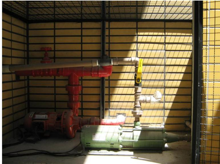
**FIGURA 3.13 – Bomba de Incêndio (Fonte: autor), 2012**
