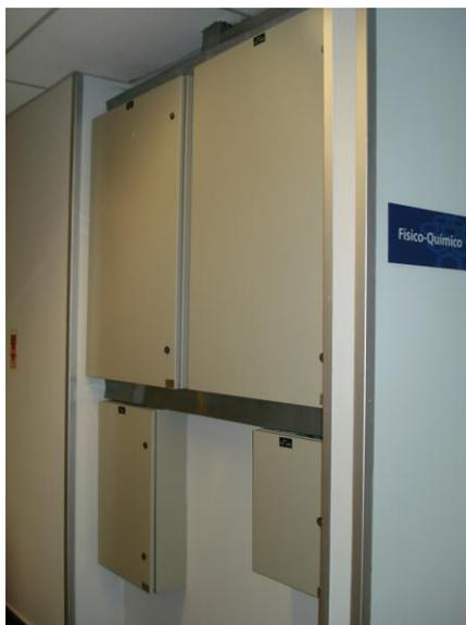
**FIGURA 6.11 - Quadros de Distribuição de Luz e Força próximo à entrada dos laboratórios do Centro de Pesquisas (Fonte: autor, 2010).**
