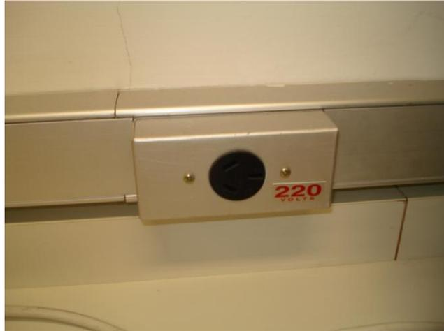
**FIGURA 3.32 – Eletrodutos em alumínio e não em cinza escuro**
