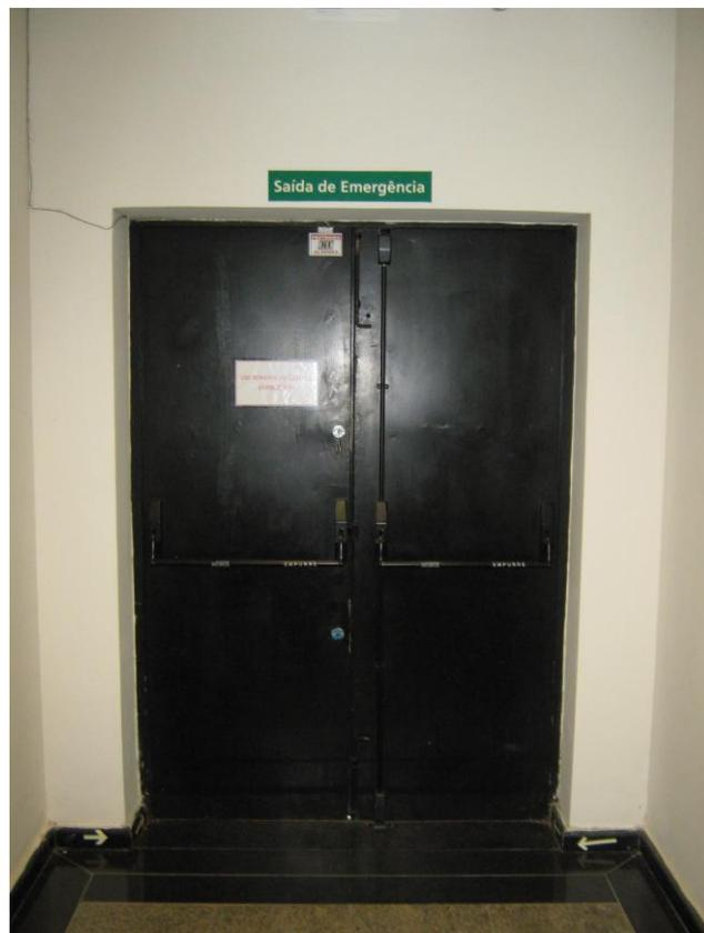
**FIGURA 3.23 – Saída de Emergência com cor errada (Fonte: autor), 2012**
