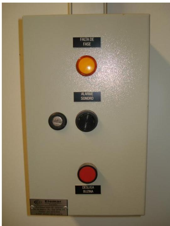
**FIGURA 3.19 – Botoeira/alarme para sistema de exaustão dos laboratórios (Fonte: autor), 2012**
