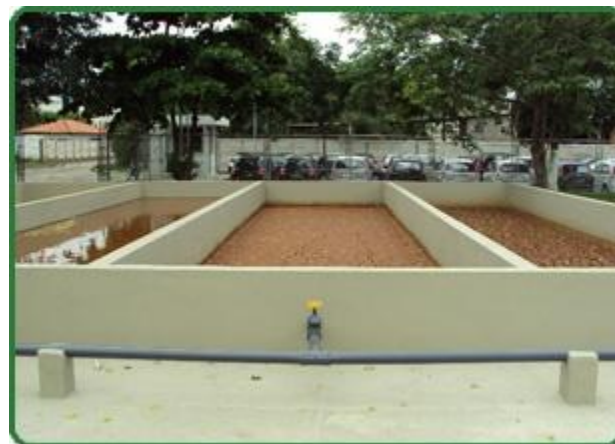
Figura 2 – Entrada do leito de secagem.
