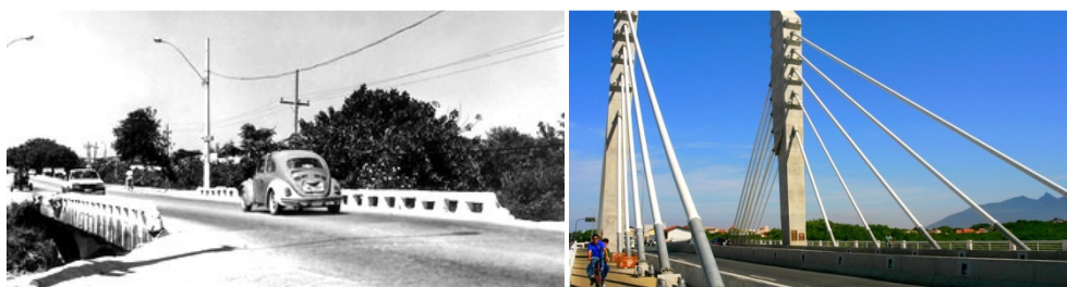
Figura 3.3 Antiga Ponte sobre o Rio das Ostras e Nova Ponte estaiada sobre o Rio das Ostras Fonte: riodasostrasinfocus.blogspot.com
