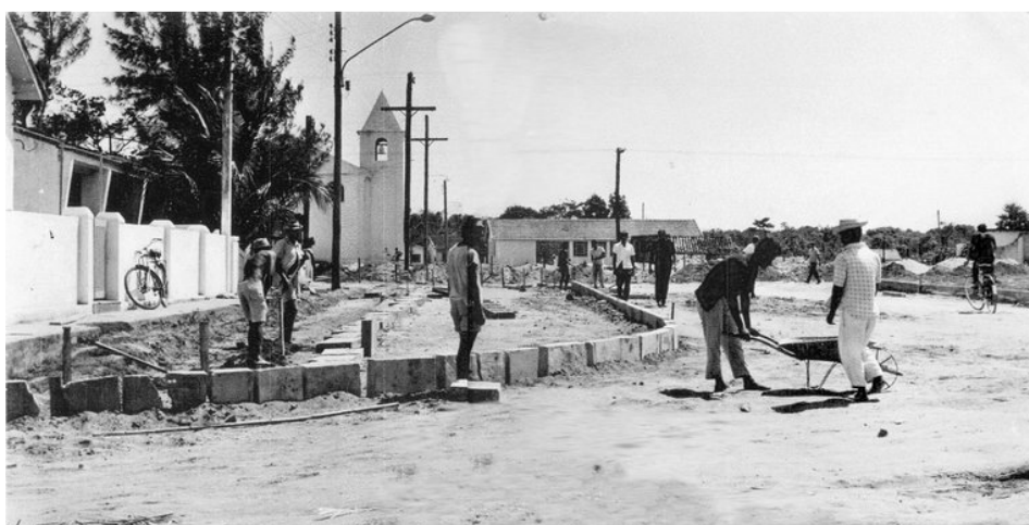
Figura 3.5 Pavimentação da rodovia Amaral Peixoto. Ao fundo, igreja marco na cidade. Fonte PMRO.
