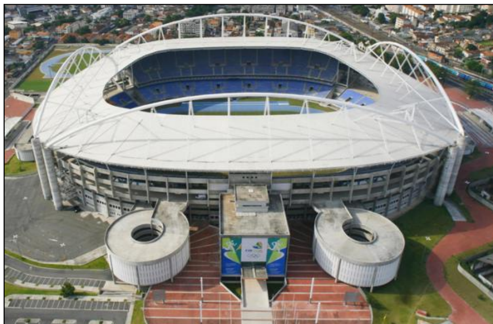
Figura 4.39: Vista aérea do Estádio Olímpico João Havelange. Fonte: Pedro Kirilos – RIOTUR.
