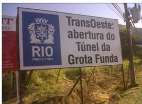
Figura 5.50: Início das obras do Túnel. Fonte: Felipe Teixeira.
