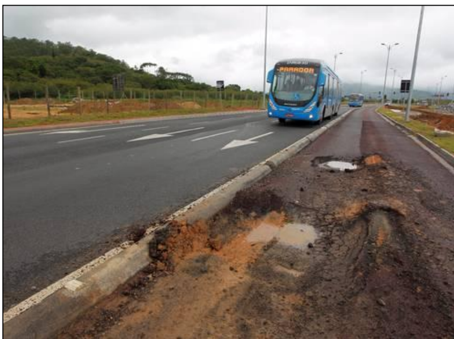
Figura 5.62: Devido a buracos na pista, o ônibus do BRT TransOeste passa fora da via exclusiva. Fonte: Custódio Coimbra – jornal O Globo em 04/01/2013.
