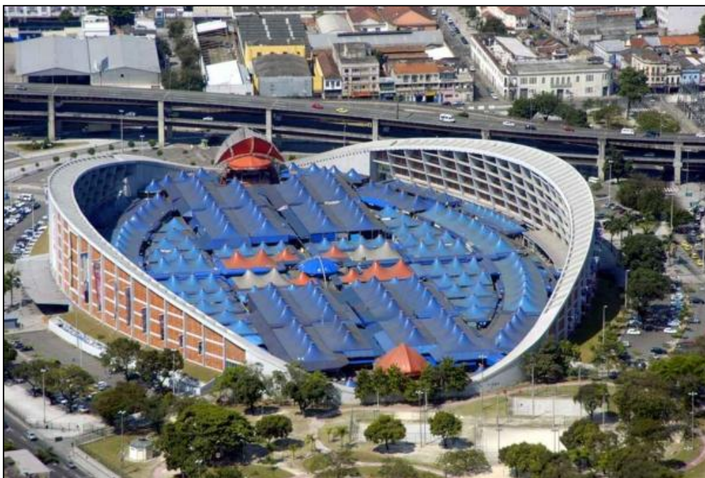
Figura 4.38: Vista aérea do Centro Luiz Gonzaga de Tradições Nordestinas. Fonte: www.sescrj.org/noticias - 23/12/12 - às 10hs27min.
