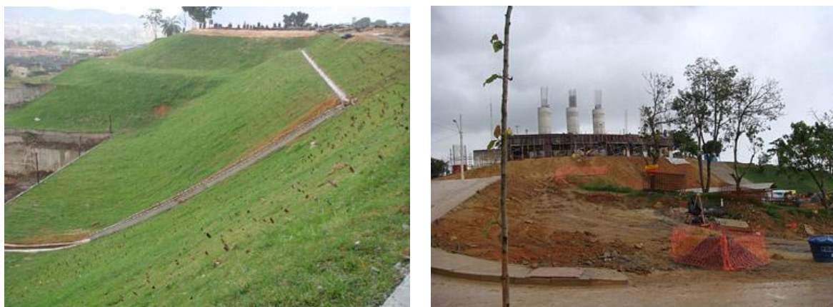
Figuras 4.63: Abertura das ruas e tratamento das encostas no Morro do Adeus
