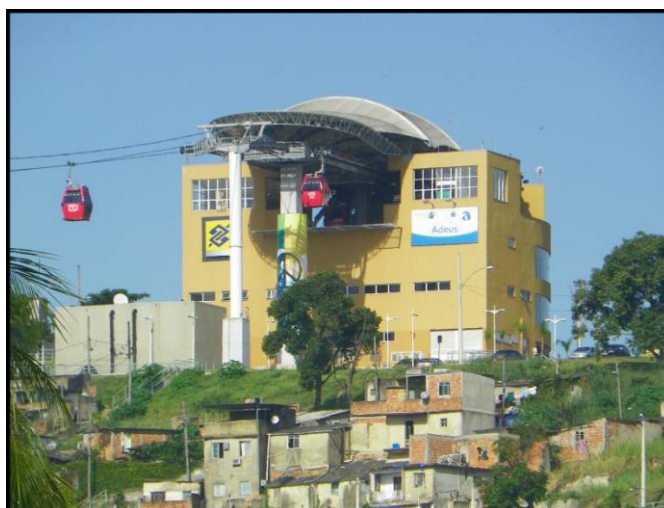
Figura 4.41: Estação do Teleférico do Alemão (Morro do Adeus). Fonte: Rosane Santos, 2012.
