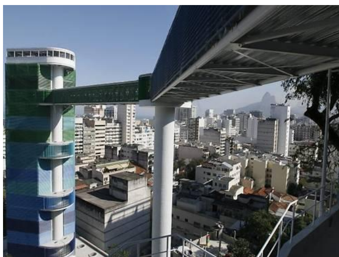
Figura 4.28: Torres do Elevador no PPG
