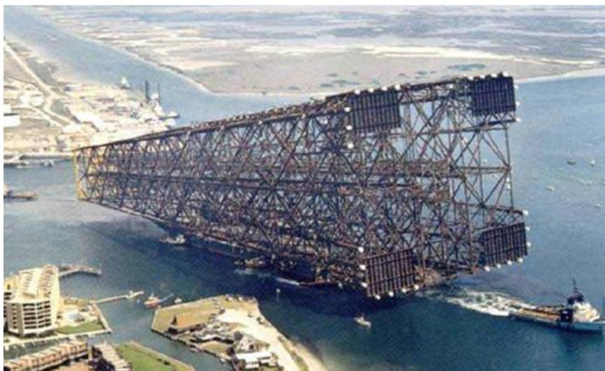
**Figura 2-3 – Jaqueta sendo transportada ao local de implantação**
