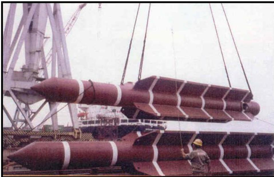
**Figura 2-21 – Estacas Torpedo**
