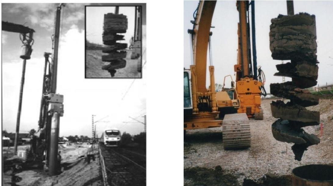
Figura 2-7: Escavação pelo método sem deslocamento (Alexiew *et al.* 2005).
