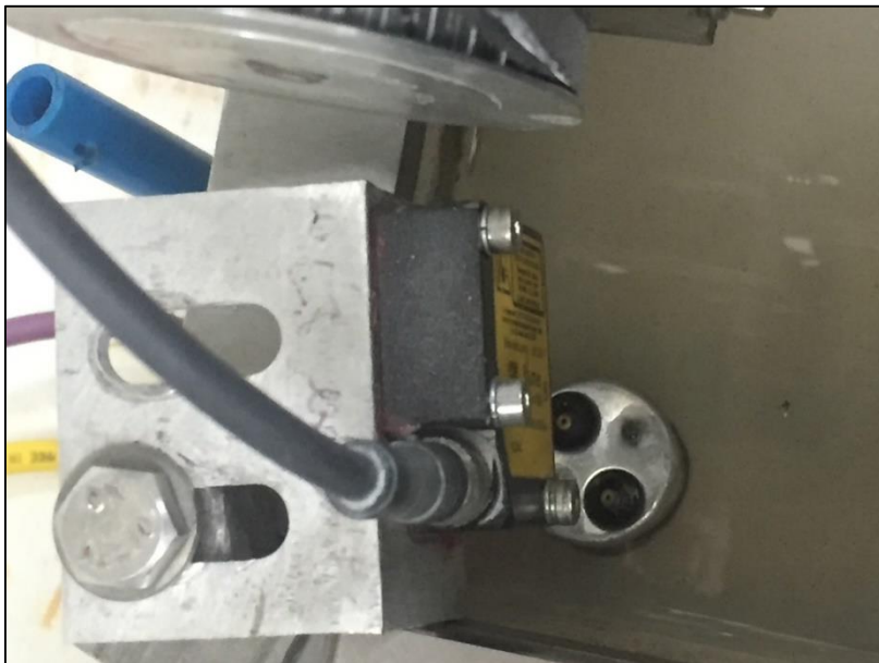
Figura 42 – Instalação do sensor de deslocamento
