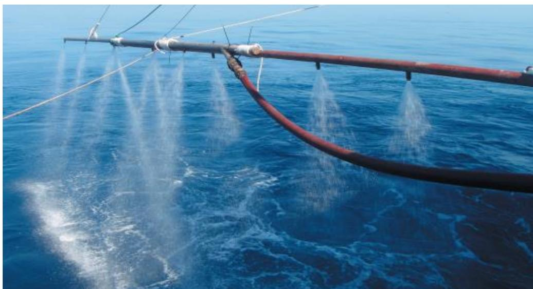
Figura 11: Pulverização de dispersantes por meio de bicos de aspersão através de um braço de dispersão montado em embarcações
