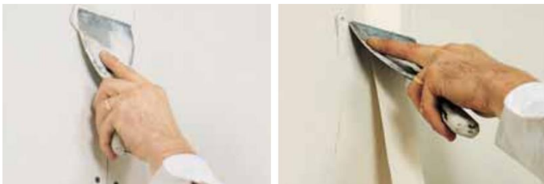
Figura 4.16: Tratamento de juntas (PLACO DO BRASIL, s.d).
