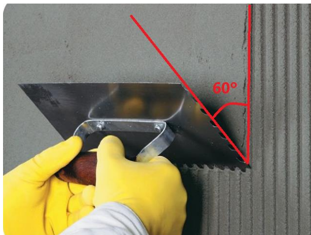
Figura 3.13: Formação dos cordões paralelos (WEBER SAINT-GOBAIN, 2020).
