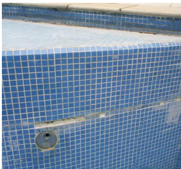
Figura 4.41: Desplacamento e fissuração (CAMARGO, 2017).
