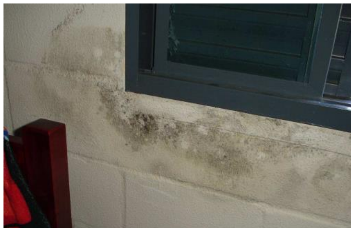
Figura 4.19: Infiltração no peitoril (MOCH, 2009).
