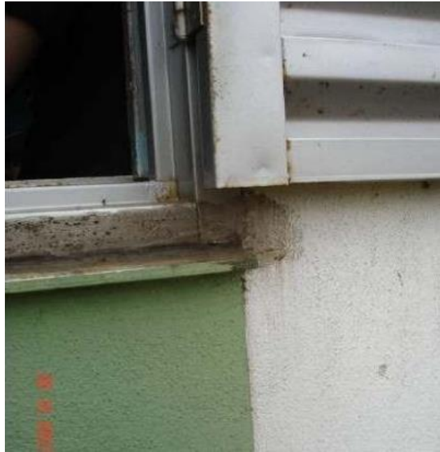
Figura 4.18: Infiltração no peitoril (MOCH, 2009).
