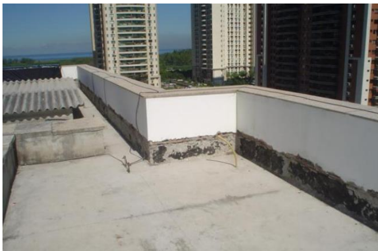
Figura 4.38: Descolamento da manta no telhado (OLIVEIRA D. F., 2013).
