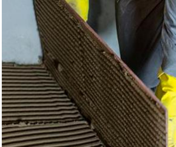
Figura 3.15: Demonstração da dupla colagem (BRUMAX, 2020).
