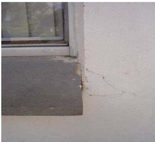
Figura 4.20 : Falta de prolongamento do peitoril em relação às arestas laterais (MOCH, 2009).
