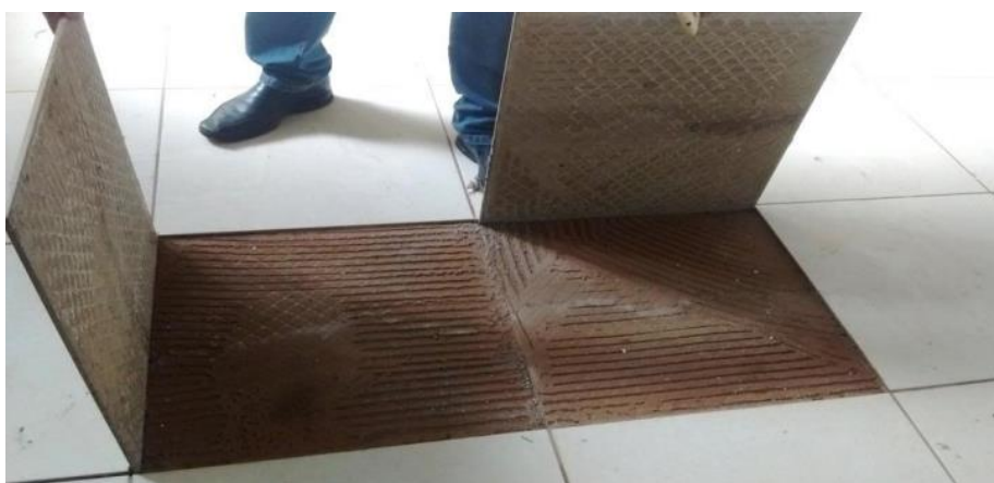
Figura 4.45: Deslocamento de cerâmicas - Falta de dupla colagem (FONSÊCA, 2018).
