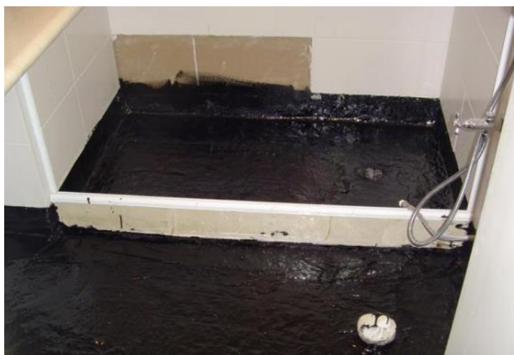
Figura 4.36: Impermeabilização flexível aplicada com a solução asfáltica e tela de poliéster (OLIVEIRA D. F., 2013).
