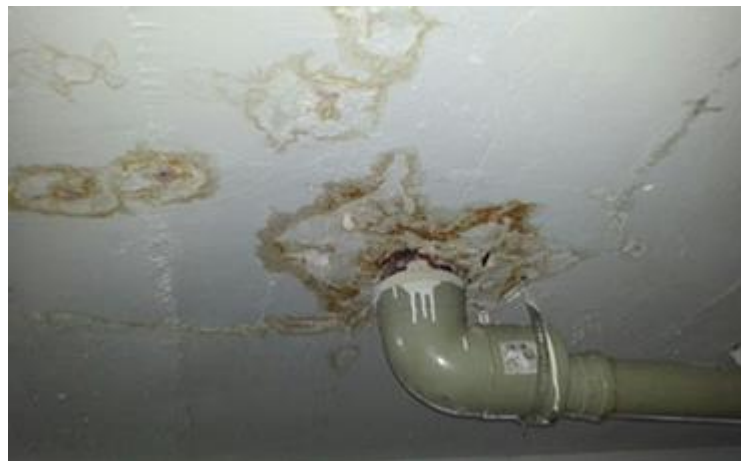
Figura 3.11: Infiltração na interface entre ralo e laje (VEDAFACIL, s.d).
