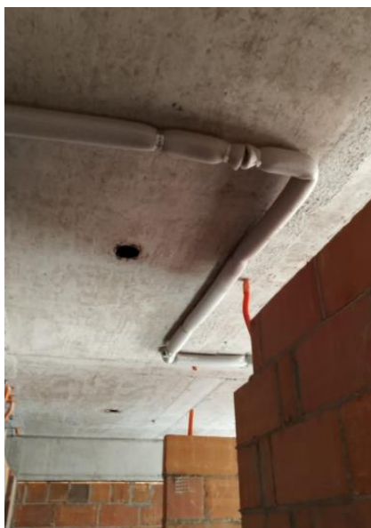
Figura 4.29: Isolamento acústico de tubulações sanitárias com espuma (O AUTOR, 2021).
