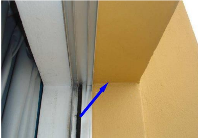
Figura 4.26 : Caso propício de infiltração pela interface janela/verga (MOCH, 2009).
