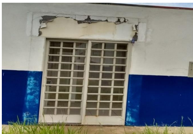
Figura 4.14: Patologia em placas de drywall (FONSÊCA, 2018).
