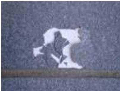
Figura 4.51: Esfolhamento (PEZZATO, 2010).
