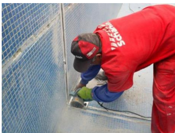
Figura 4.49: Execução do corte para junta de movimentação (CAMARGO, 2017).
