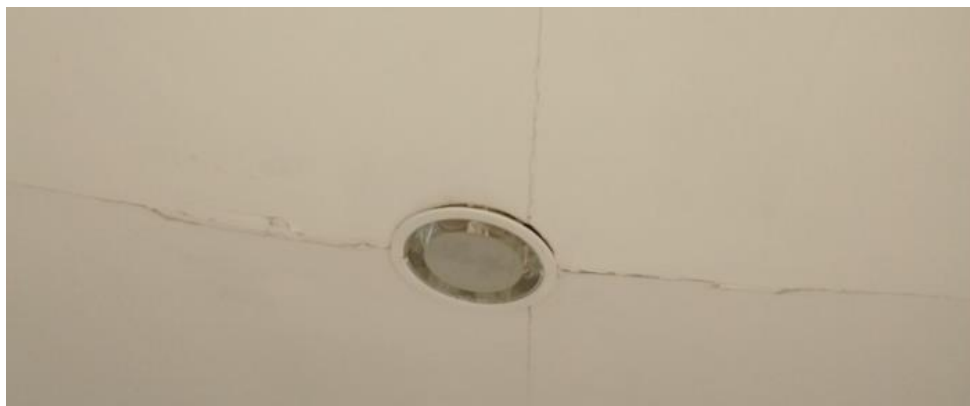
Figura 4.54: Fissura no forro de gesso (FONSÊCA, 2018).
