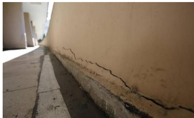
Figura 4.11: Fissura no muro da platibanda na interface entre a manta asfáltica e alvenaria (O GLOBO, 2014).
