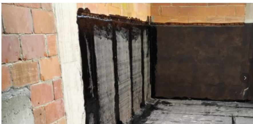
Figura 4.39: Instalação correta da manta, realizando a ancoragem na alvenaria (O AUTOR, 2021).
