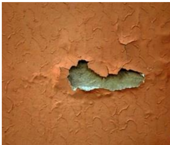
Figura 4.62: Desagregação (JERÔNIMO NETO, 2007).
