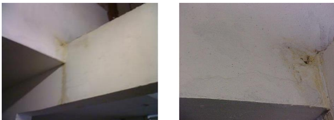
Figura 4.34: Infiltrações (CAMARGO, 2017).
