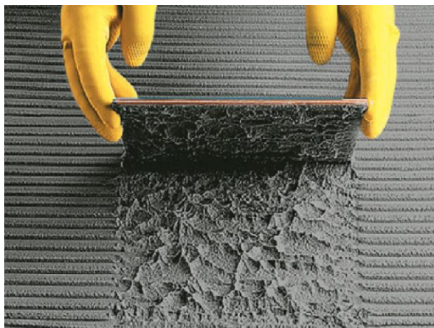
Figura 3.17: Aspecto de aderência desejado após aplicação da cerâmica (WEBER SAINT-GOBAIN, 2020).
