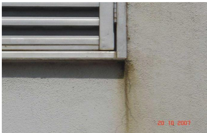
Figura 4.21: Sujidade devido ao prolongamento insuficiente do peitoril (MOCH, 2009).
