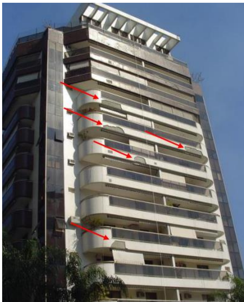
Figura 4.43: Deslocamento de pastilha. Fachada apresentando pontos com som cavo (OLIVEIRA D. F., 2013).
