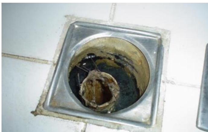
Figura 4.37: Altura de corte do pescoço do ralo (OLIVEIRA D. F., 2013).
