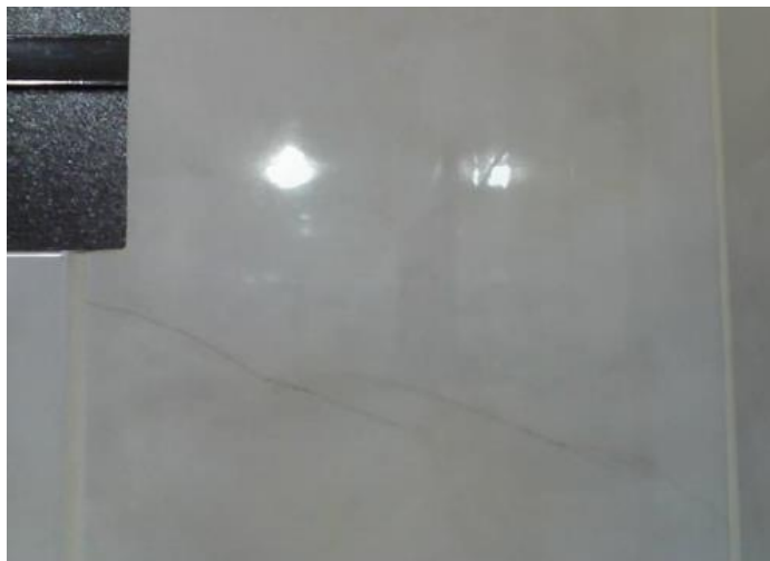
Figura 4.13: Fissura devido à ausência de contraverga (MOCH, 2009).
