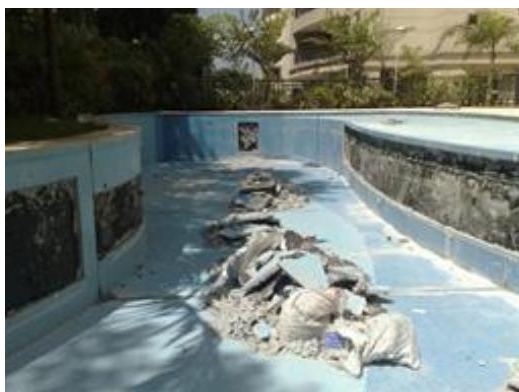
Figura 4.42: Retirada do revestimento (CAMARGO, 2017).
