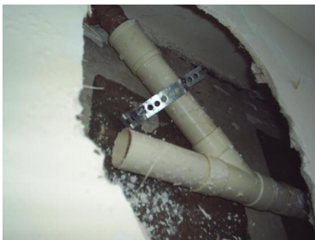
Figura 3.18: Ramal secundário de esgoto incompleto (OLIVEIRA D. F., 2013).
