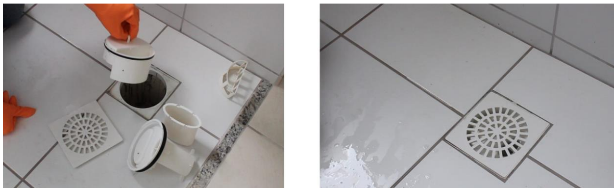
Figura 4.31: Instalação ralo antiespuma (CMO CONSTRUTORA, 2017).
