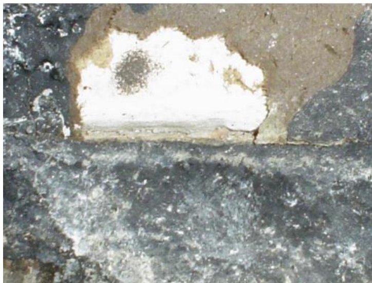
Figura 4.35: Impermeabilização rígida danificada junto a placa de drywall (OLIVEIRA D. F., 2013).
