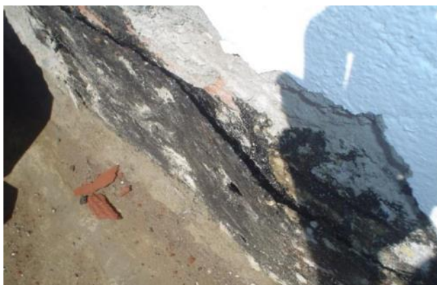
Figura 3.9: Descolamento da manta por não ancoramento (OLIVEIRA D. F., 2013).
