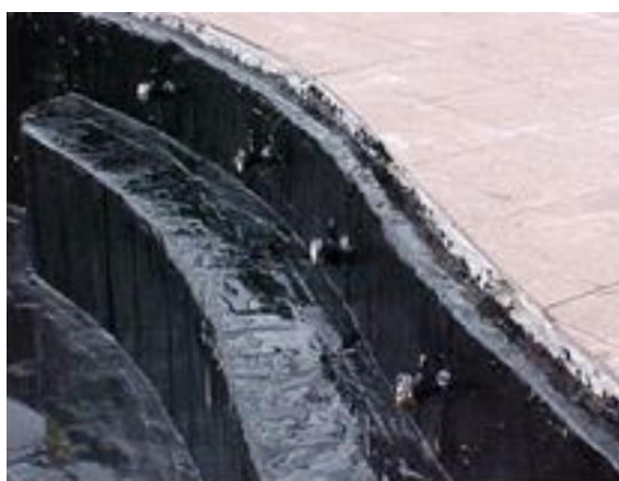
Figura 3.7: Execução impermeabilização (CAMARGO, 2017).
