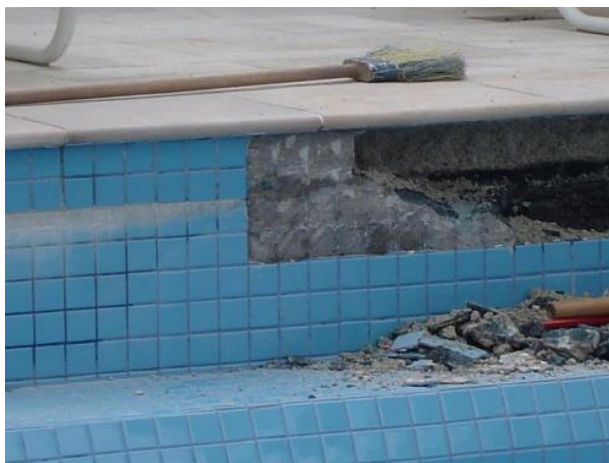
Figura 3.8: Ocorrência de infiltração quando a virada da manta não se estende até a borda da piscina, necessitando reparos (OLIVEIRA D. F., 2013).
