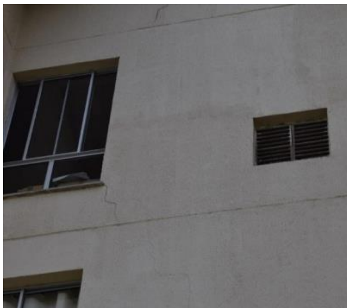
Figura 4.12: Fissura devido à ausência de contraverga (CARMO & SILVA, 2017).
