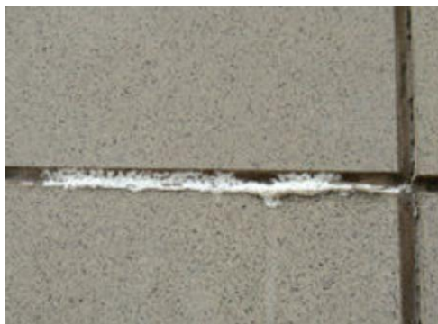
Figura 4.53: Eflorescência (PEZZATO, 2010).
