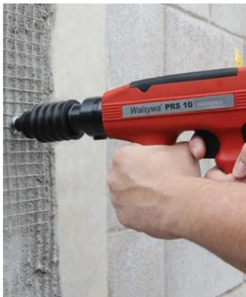
Figura 3.1: Fixação tela para alvenaria (WALSYWA, 2019).
