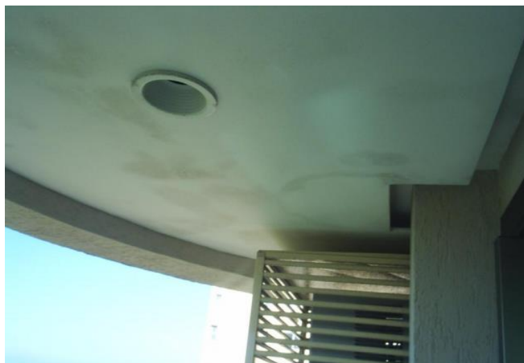
Figura 4.56: Presença de mofo e bolor em varanda devido ao uso de tinta inadequada para o ambiente (OLIVEIRA D. F., 2013).
