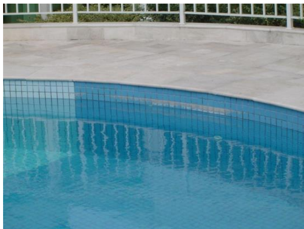
Figura 4.52: Sinais de eflorescência na borda da piscina (OLIVEIRA D. F., 2013).
