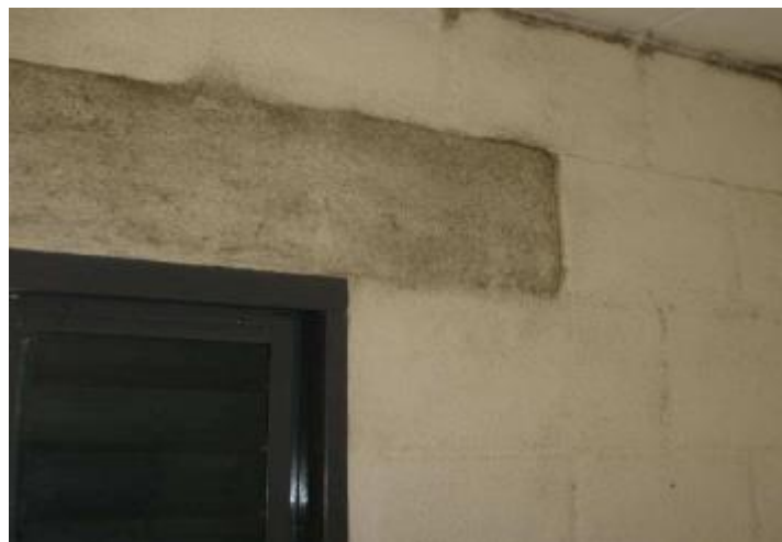
Figura 4.25: Presença de mancha de umidade devido infiltração próximo à verga (MOCH, 2009).
