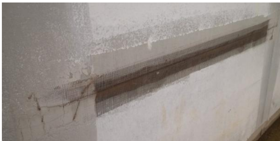
Figura 4.15: Processo de tratamento de junta incompleto (FONSÊCA, 2018).
