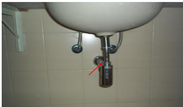
Figura 4.28: Incorreta instalação do sifão da pia (OLIVEIRA D. F., 2013).
