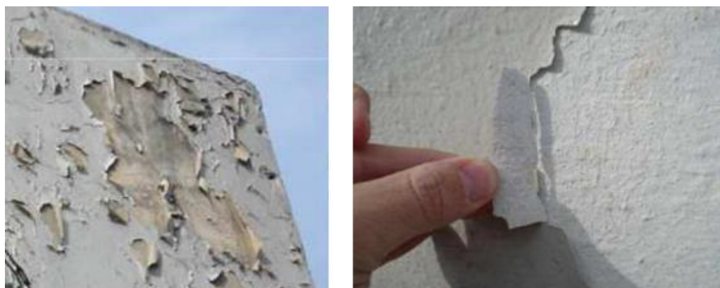
Figura 4.59: Descascamento (GONZAGA, 2011).
