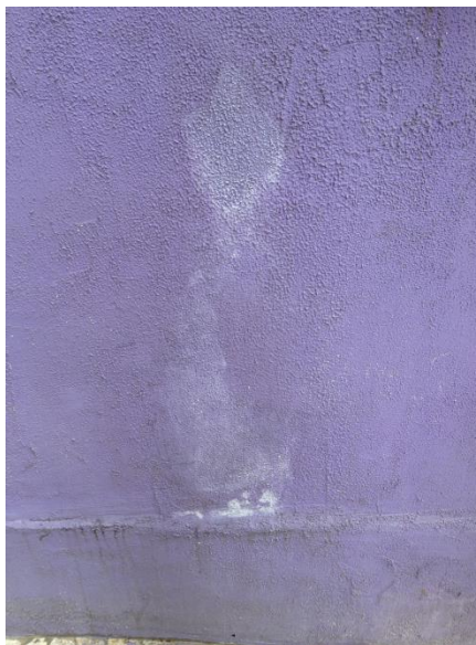
Figura 4.58: Exemplo de eflorescência (MARRA, 2013)
