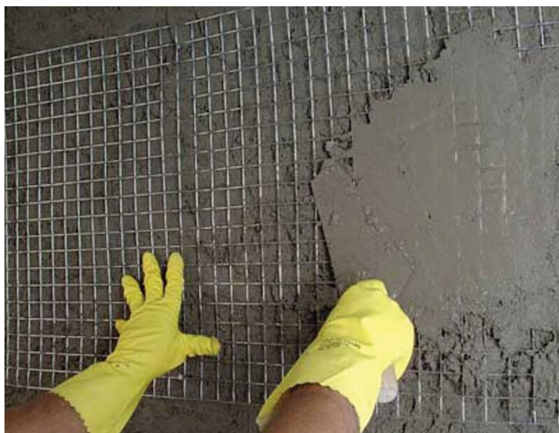
Figura 4.3: Reforço com tela metálica (TECIAM, s.d).
