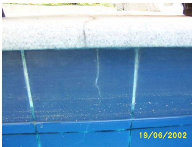
Figura 4.48: Micro fissuras em piscina (PEZZATO, 2010).
