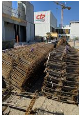
Figure 30 : zone de stockage de coutures de prédalle.
