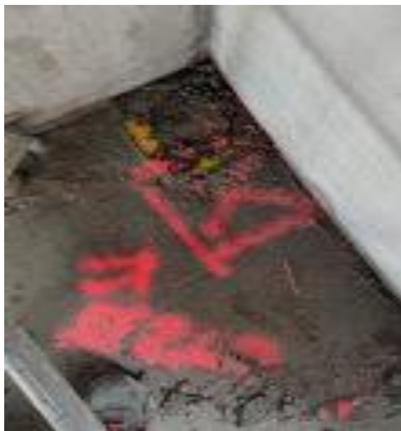
Figure 46 : réservation à carotter.
