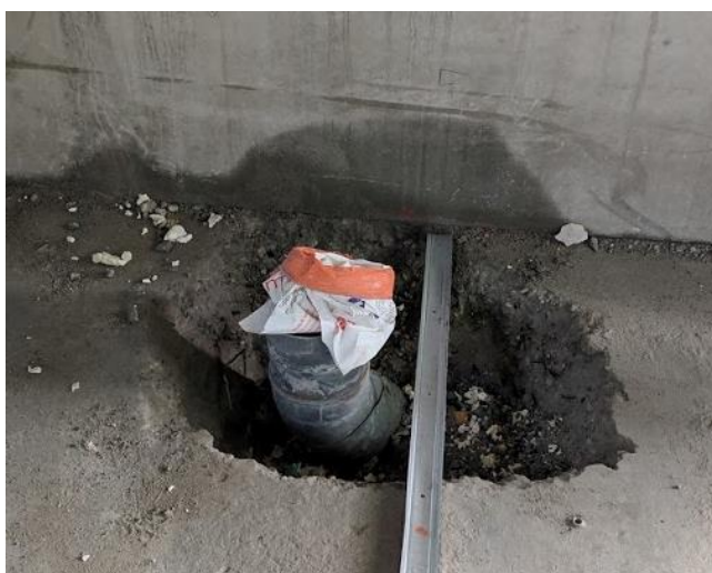
Figure 55 : attente placée au-dessous d'un rail de placos.
