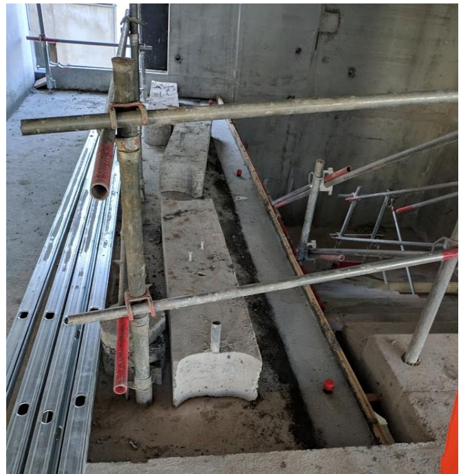
Figure 62 : palier d'escalier scié et chaînage recomposé après.
