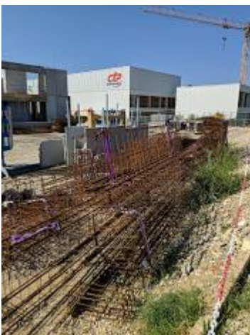
Figure 29 : zone de stockage d'armatures de poteaux, poutres et relevés.
