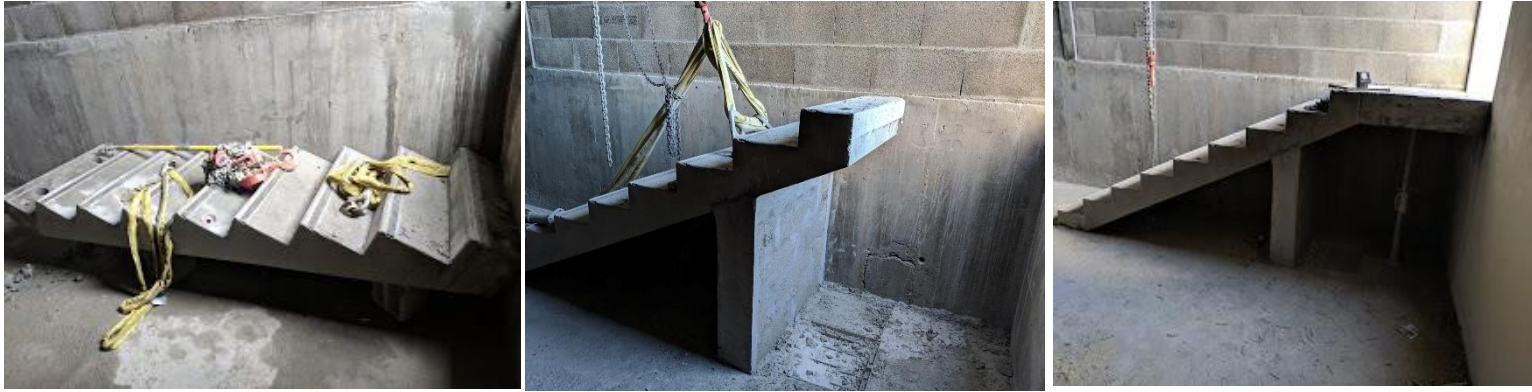
Figure 63 : sciage d'escalier et réalisation d'un palier.
