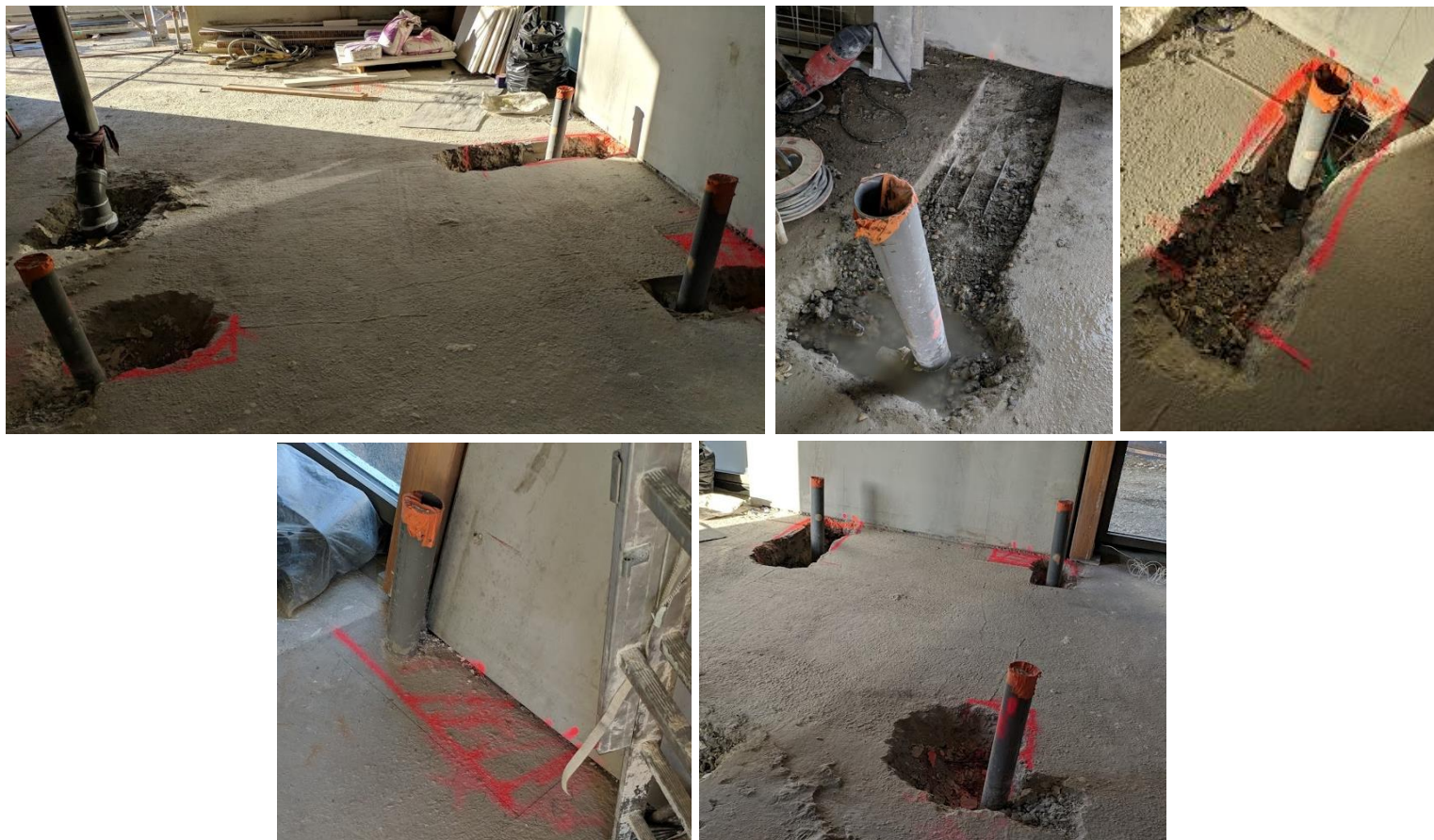
Figure 57 : reprise des réseaux sous-dallage.
