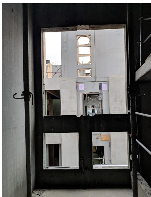
Figure 60 : sciage de jambage en étapes.
