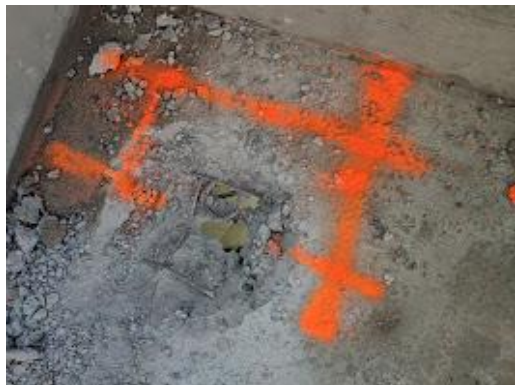
Figure 45 : réservation à piquer.
