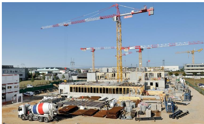
Figure 33 : état d'avancement des travaux lors de mon arrivée sur le chantier.
