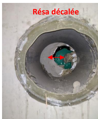
Figure 37 : résas décalées en double mur (sous-sol du bâtiment Q « rue »).
