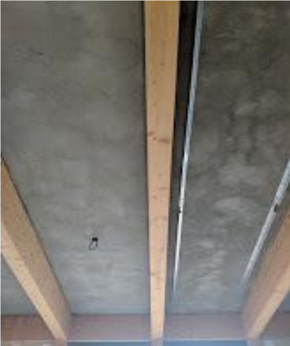
Figure 70 : prédalle poncée (à gauche) et prédalle non poncée (à droite).
