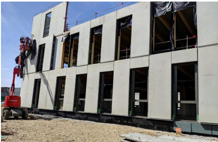
Figure 68 : pose des MOBs..
