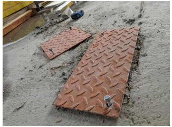
Figure 50 : plaques métalliques sur réservations.
