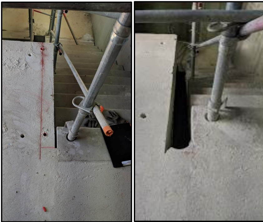
Figure 61 : sciage de palier d'escalier.
