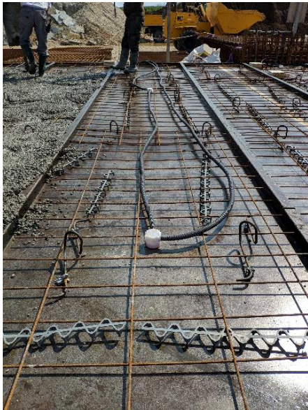
Figure 22 : prédalle en préparation.
