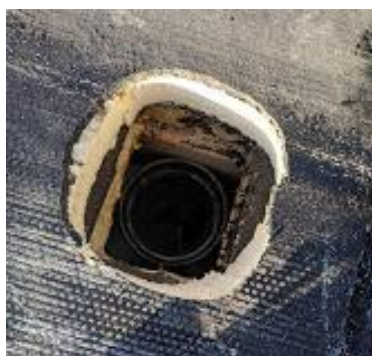
Figure 47 : réservation destinée à recueillir les eaux pluviales, avant la finition de l'étanchéité.
