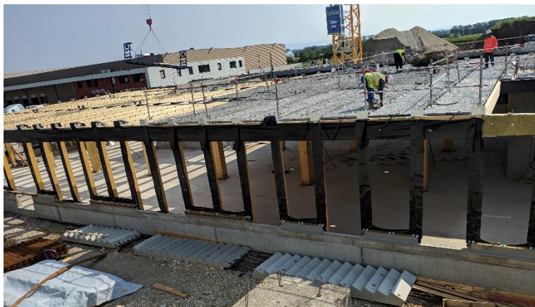
Figures 15 et 16 : pose de la charpente bois, des prédalles et des murs béton armé.
