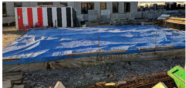
Figure 24 : banc de prédalles (avec prédalles en maturation).
