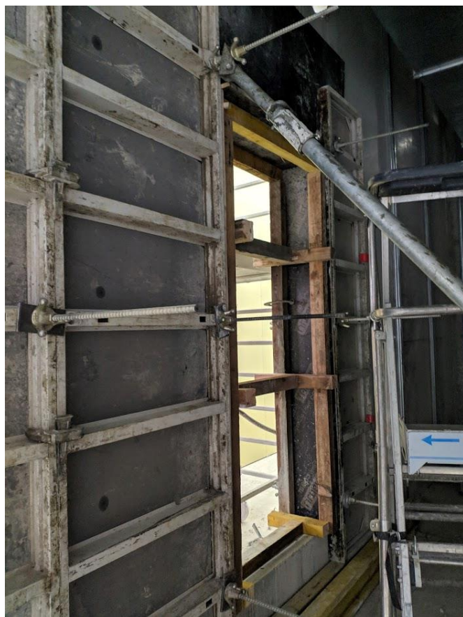
Figure 67 : coffrage finalisé et coulage.
