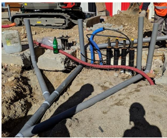
Figure 52 : réseaux sous-dallage (eaux, CVC et électriques) bâtiment L.
