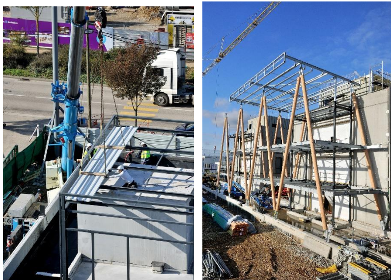
Figure 20 : pose de la charpente métallique et montage de la rue.
