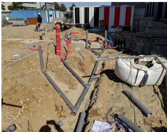
Figure 51 : réseaux sous-dallage bâtiment L.
