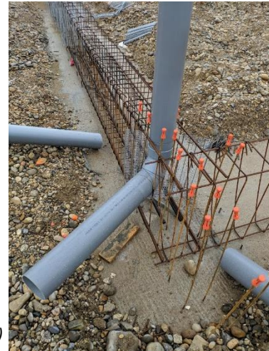
Figure 53 : implantation d'une attente dans l'armature d'une longrine du bâtiment L.
