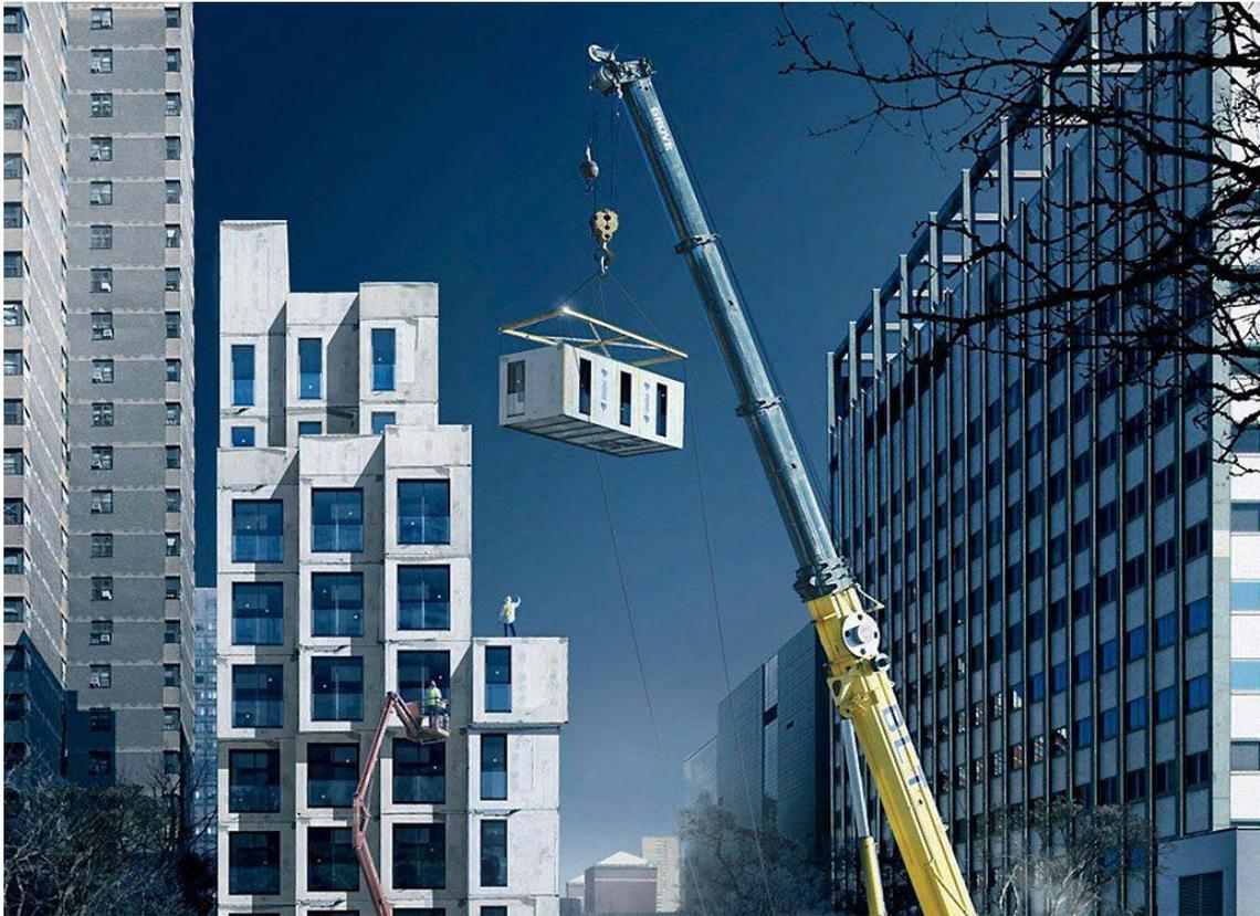
Figura 3.4 – Exemplo de painel 3D finalizado e sendo alçado, com janelas, portas (SMART, 2020)
