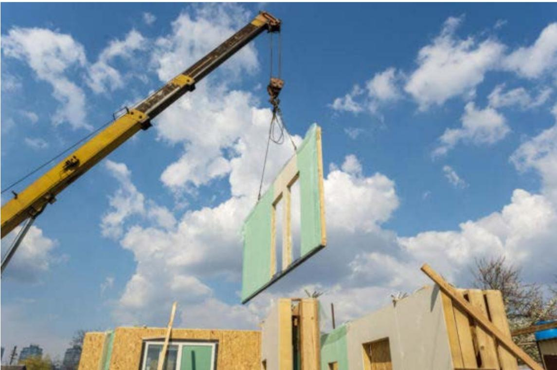
Figura 3.2 – Módulo 2D de madeira sendo elevado por um guindaste (HABITABILITY, 2022)
