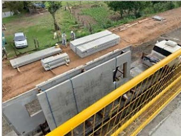
Figura 4.3 – Exemplo de módulo em concreto (BPM PRÉ-MOLDADOS, 2020)
