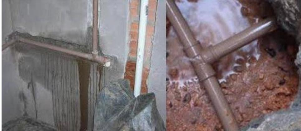
Figura 2.8 Vazamento de tubulações resulta em umidade acidental (NEOIPSUM, 2021).
