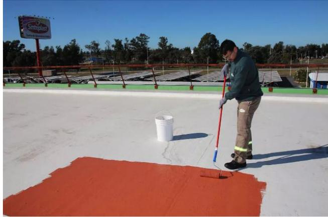
Figura 3.1. Aplicação de membrana de poliuretano (MARTEL, 2019)
