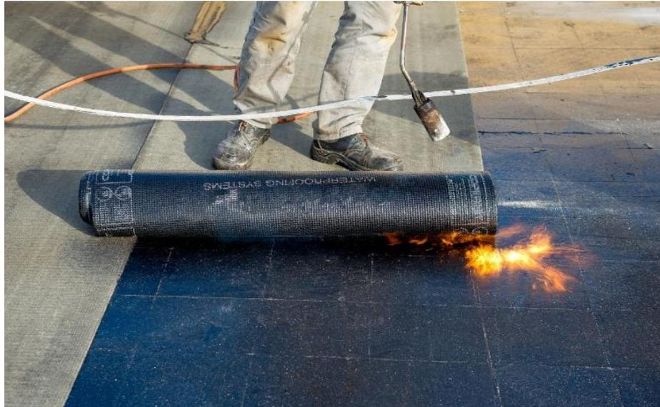
Figura 3.3 Aplicação de manta asfáltica (FIBERSALS, 2021).
