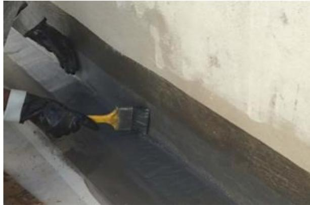
Figura 6.4 Tratamento dos cantos entre piso e parede com aplicação de poliuretano (AUTOR).
