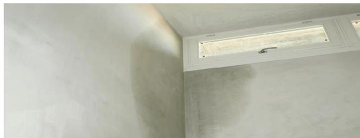
Figura 2.5 Umidade por infiltração parede/basculante devido a falha no elemento construtivo (SHUTTERSTOCK, 2017).
