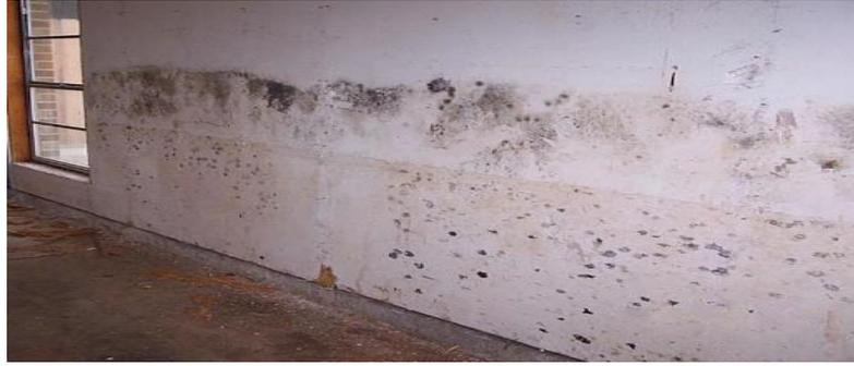
Figura 4.4 Manchas de mofo pela umidade (CONSTRUDEIA, 2013).
