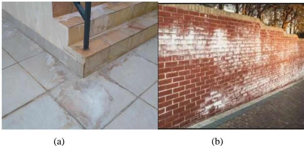
Figura 4.5 Eflorescência: a) piso (TOTALCONTRUÇÃO, 2020); b) parede (VIVADECORA, 2022).
