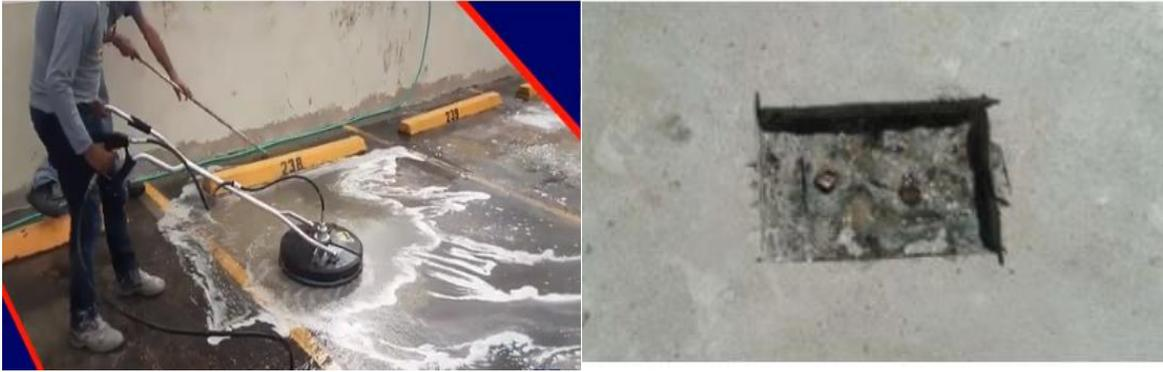
Figura 5.13. Limpeza da superfície e tratamento de ferragens no concreto (ALCHEMCO, 2023)
