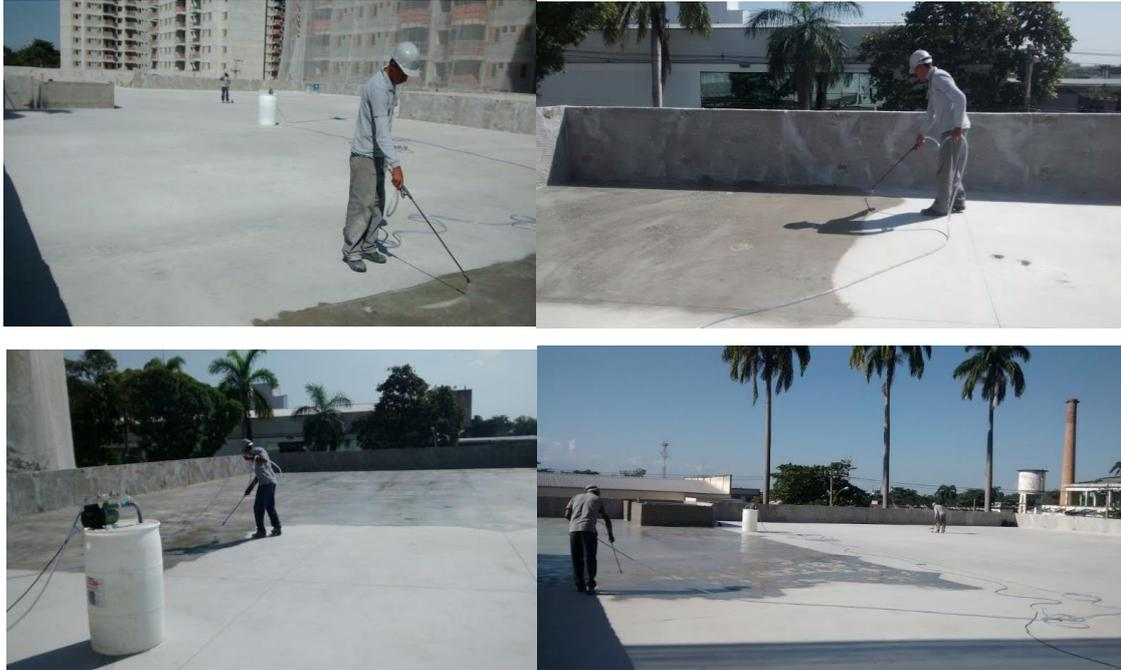
Figura 6.3 Desenvolvimento da aplicação do produto na laje de estacionamento (AUTOR).
