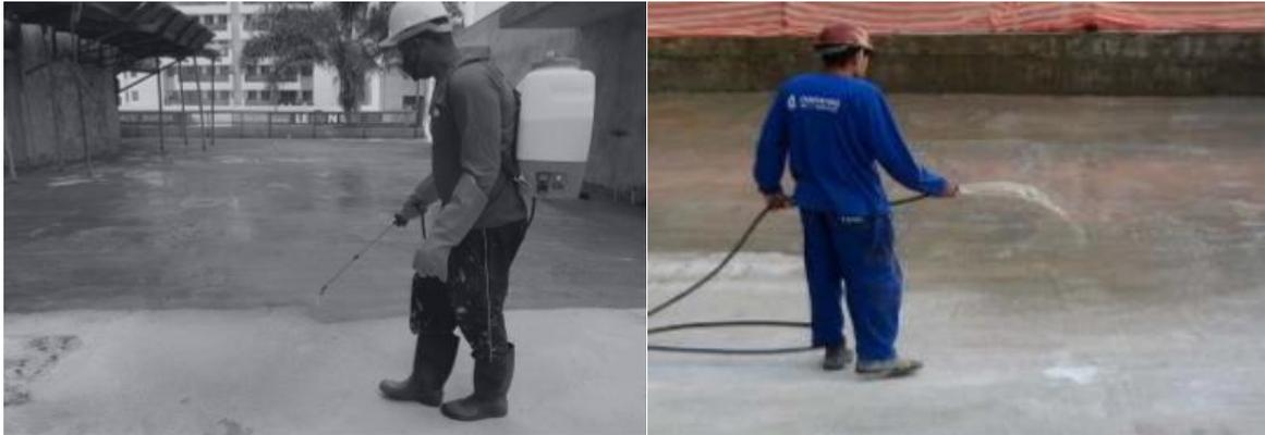
Figura 5.14 Aplicação do silicato bioquimicamente modificado e a 1ª hidratação (ALCHEMCO, 2023).
