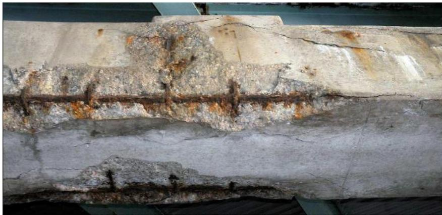
Figura 4.6. Carbonatação do concreto (TECNOSIL, 2023).
