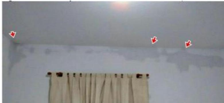
Figura 4.3 Mancha de umidade (MAGALHÃES et al., 2019).
